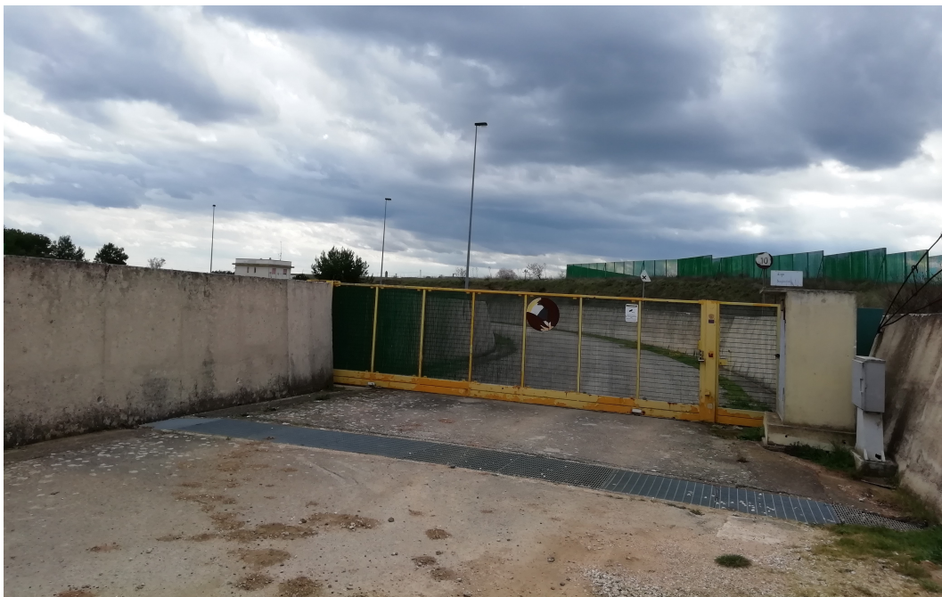
Masseria Spota – censita come unità collabente – inaccessibile L'immobile si trova all'interno della diga Sagliocchia
