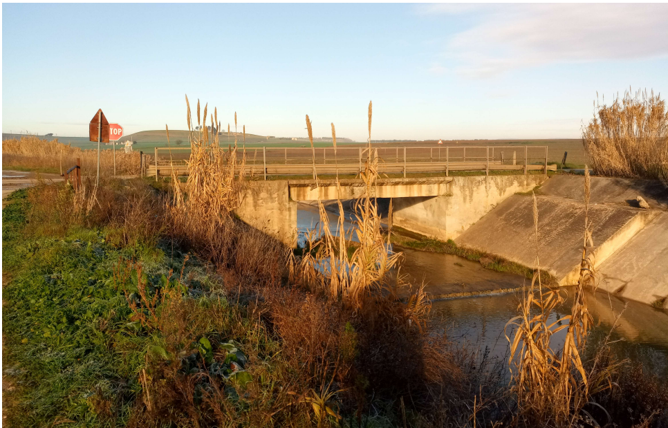
Gravina di Matera, a nord dell'area di progetto, in prossimità della SP 11
