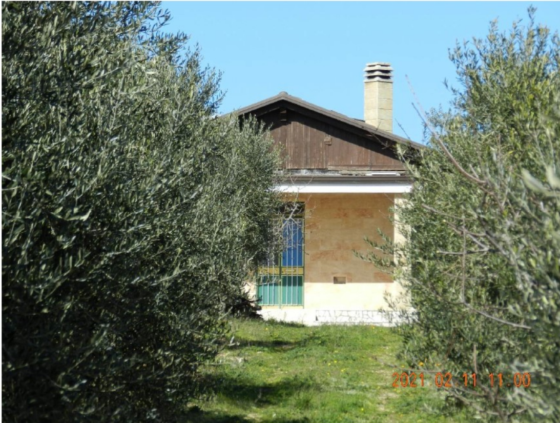
Figura 9: Punto di Vista n° 3, lato Sud Sud-Est
