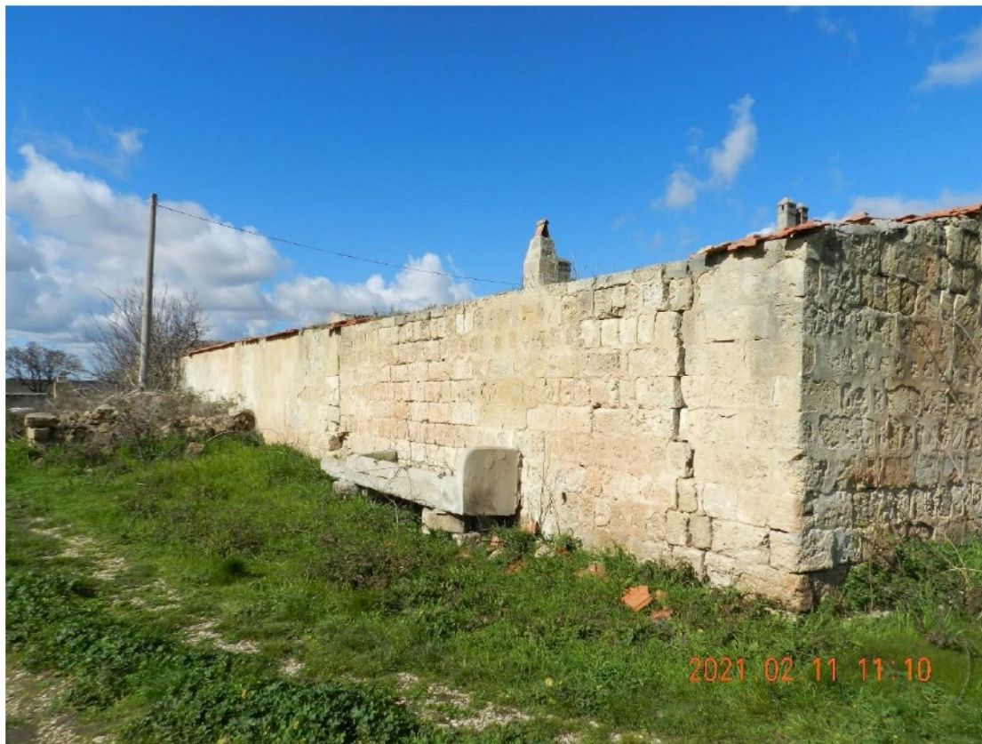
Figura 28: Punto di Vista n° 3, lato Sud
