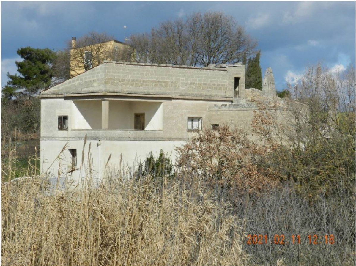
Figura 18: Punto di Vista n° 1, lati Sud Sud-Est e Sud-Ovest
