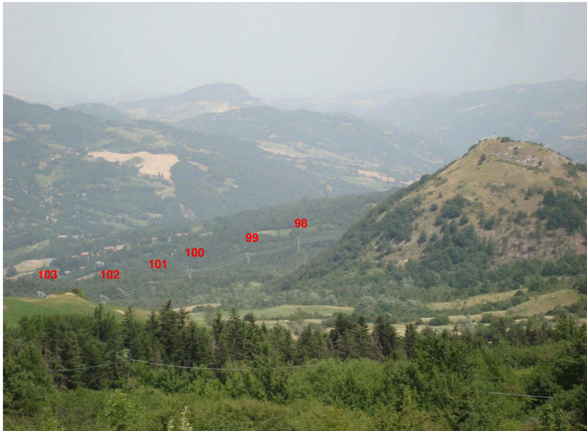
**Figura 13: PDV 3 - STATO DI PROGETTO CON SOSTEGNI A TRALICCIO - Vista dall'area di sosta panoramica del Passo della Raticosa. Sono visibili il sostegno tubolare 98 (h=46.7) e sostegni a traliccio 99 (h=37.4), 100 (h=37.4), 101 (h=37.4), 102 (h=38.5), 103 (h=37.4).**
