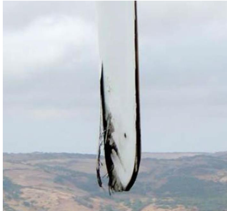
Figura 1 - Estremità della pala danneggiata da fulminazione atmosferica
