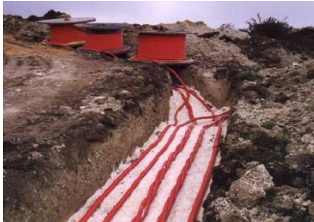
Esempio di posa in opera di un cavidotto interrato
