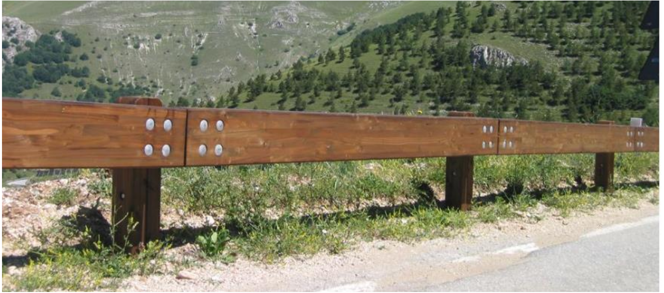
Figura 3-24: Esempio di barriere in acciaio e legno di classe N2
