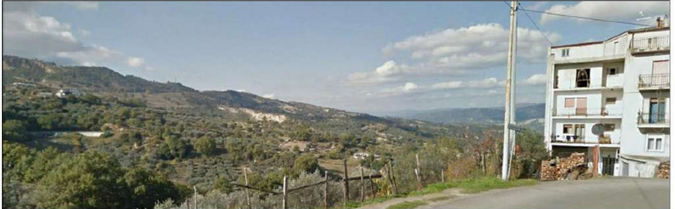
PUNTO 1: ALIANO - Via Mercato - Post operam
