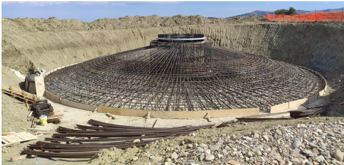
Figura 4: armatura plinto tipo
