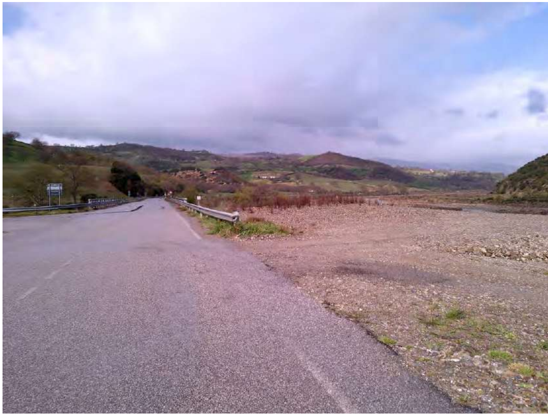
Figura 7 Area di trasbordo – Strada Provinciale SP 2
