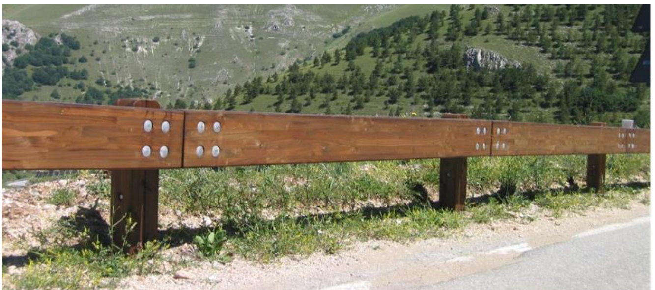
Figura 5-10: Esempio di barriere in acciaio e legno di classe N2
