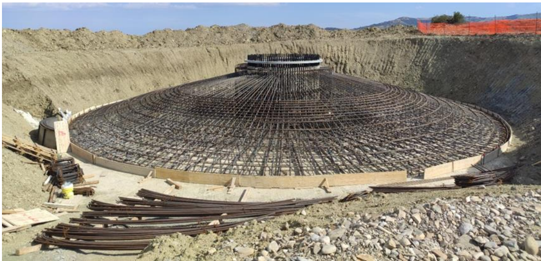
Figura 5-4: immagine tipo armature plinto
