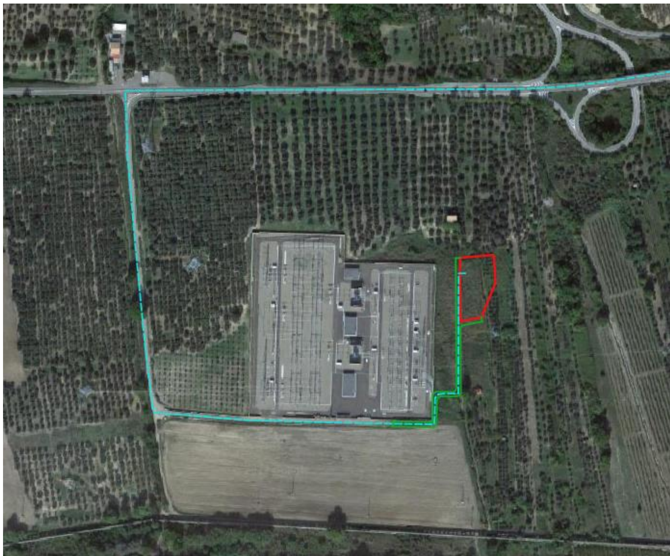
Figura 5-16: Ortofoto area di futura Stazione elettrica utente adiacente alla Stazione Terna "Aliano"
