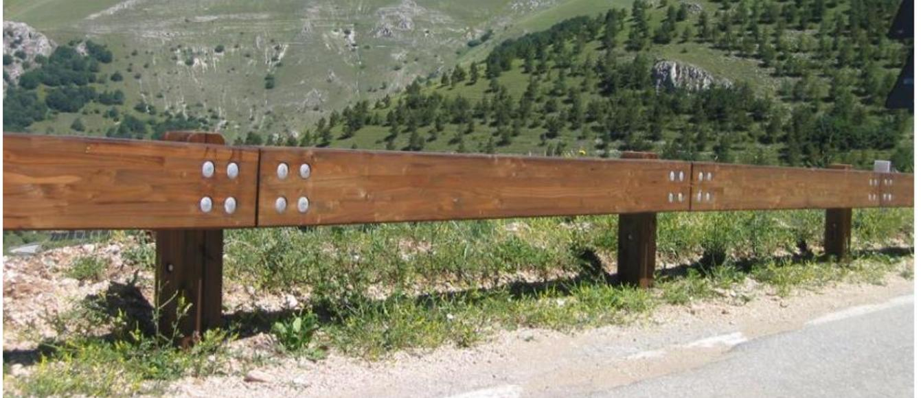
**Figura 2.8-4: Esempio di barriere in acciaio e legno di classe N2**
