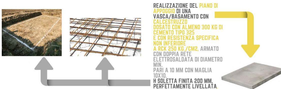
Figura 19 - Realizzazione del piano di appoggio delle vasche di fondazione delle cabine
