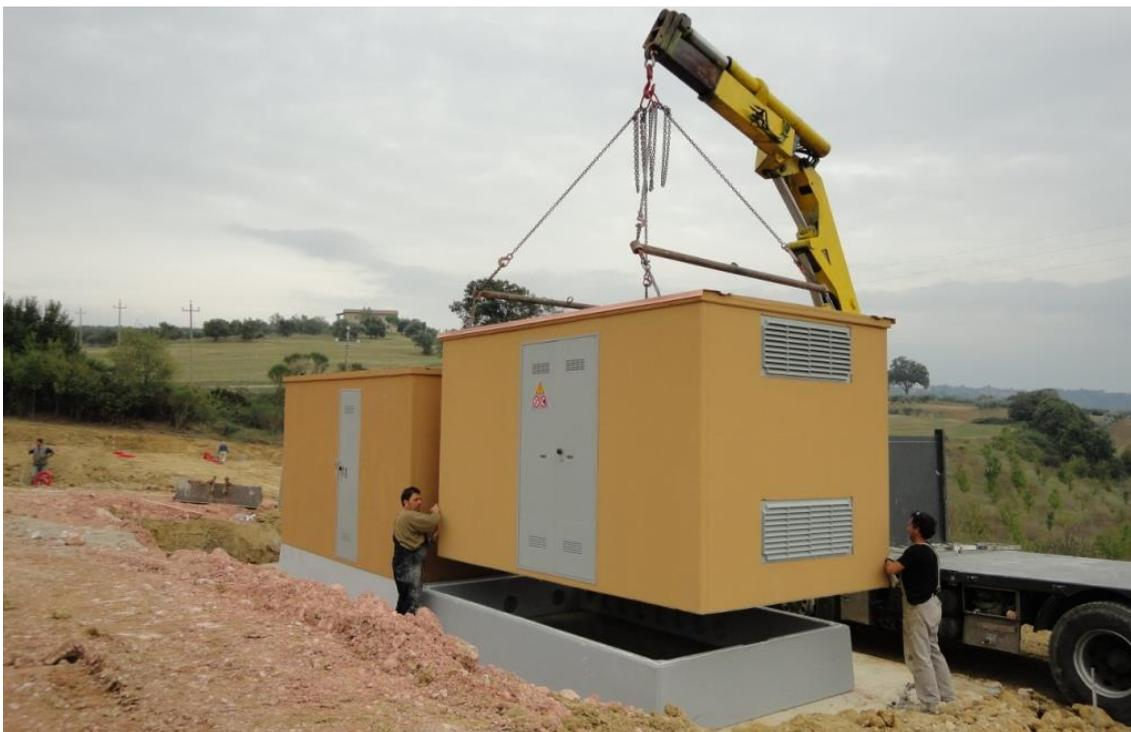
*Figura 20 - Installazione cabine elettriche prefabbricate*
