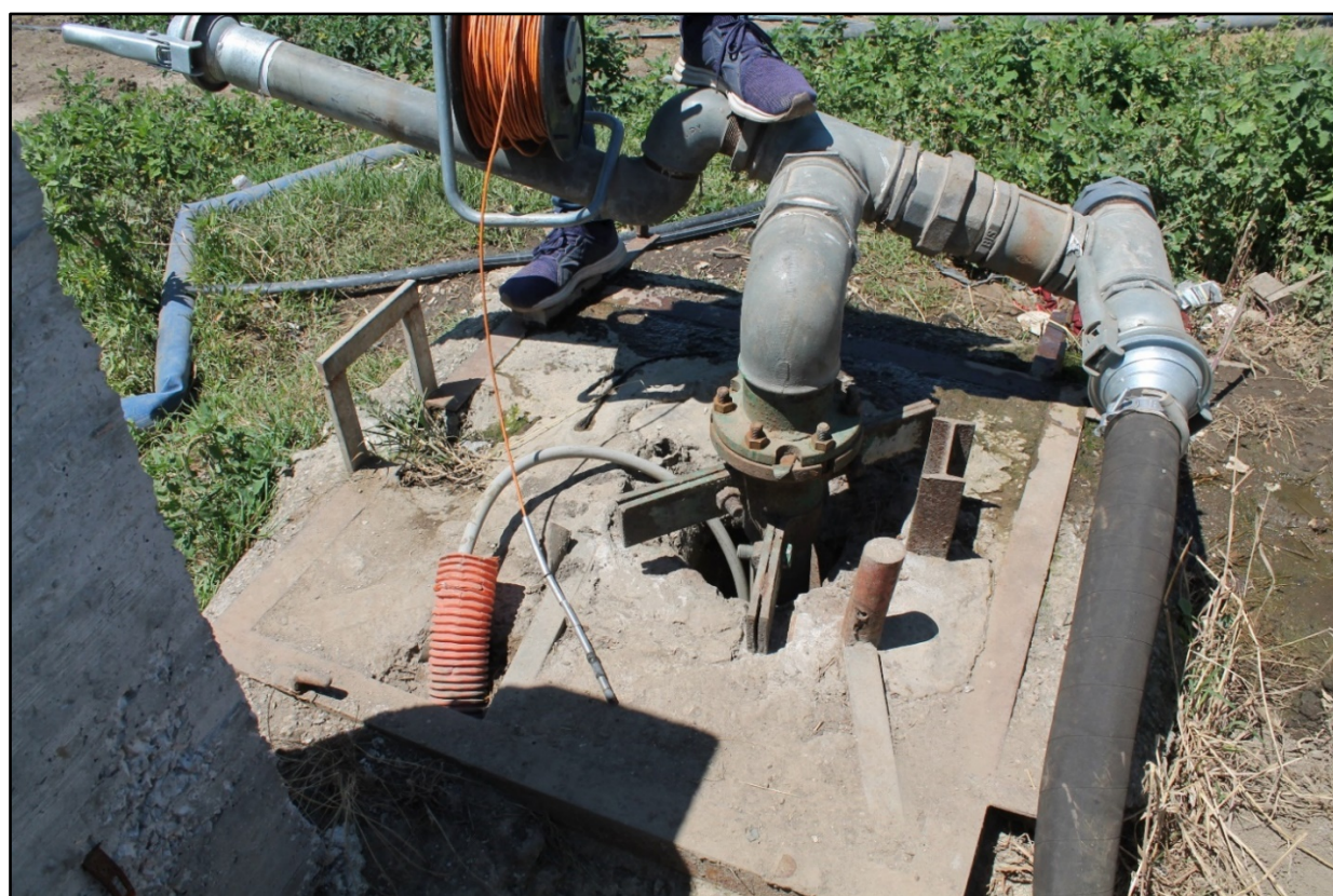
Foto 9 – Misura della falda freatica in un pozzo ubicato nel lotto di terreno “Campo 2 Sud”
