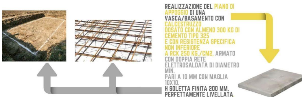
Realizzazione del piano di appoggio delle vasche di fondazione delle cabine
