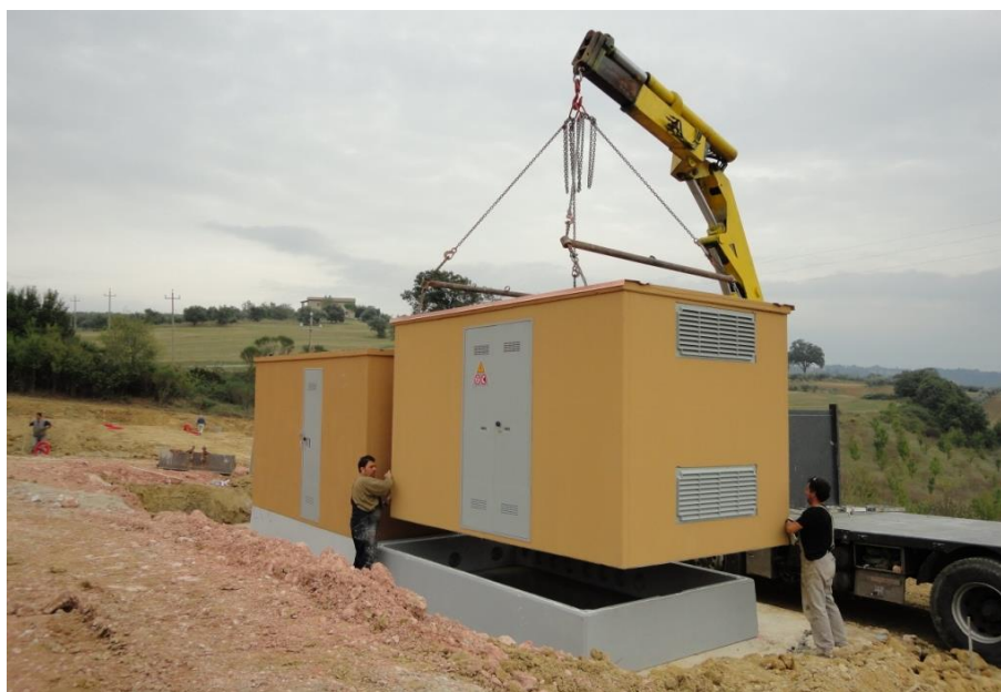
Installazione cabine elettriche prefabbricate
