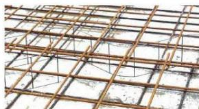
**REALIZZAZIONE DEL PIANO DI APPOGGIO DI UNA VASCA/BASAMENTO CON CALCESTRUZZO DOSATO CON ALMENO 300 KG DI CEMENTO TIPO 325 E CON RESISTENZA SPECIFICA NON INFERIORE A RCK 250 KG./CM<sup>2</sup>, ARMATO CON DOPPIA RETE ELETTROSALDATA DI DIAMETRO MIN. PARI A 10 MM CON MAGLIA 10X10. H SOLETTA FINITA 200 MM. PERFETTAMENTE LIVELLATA.**
