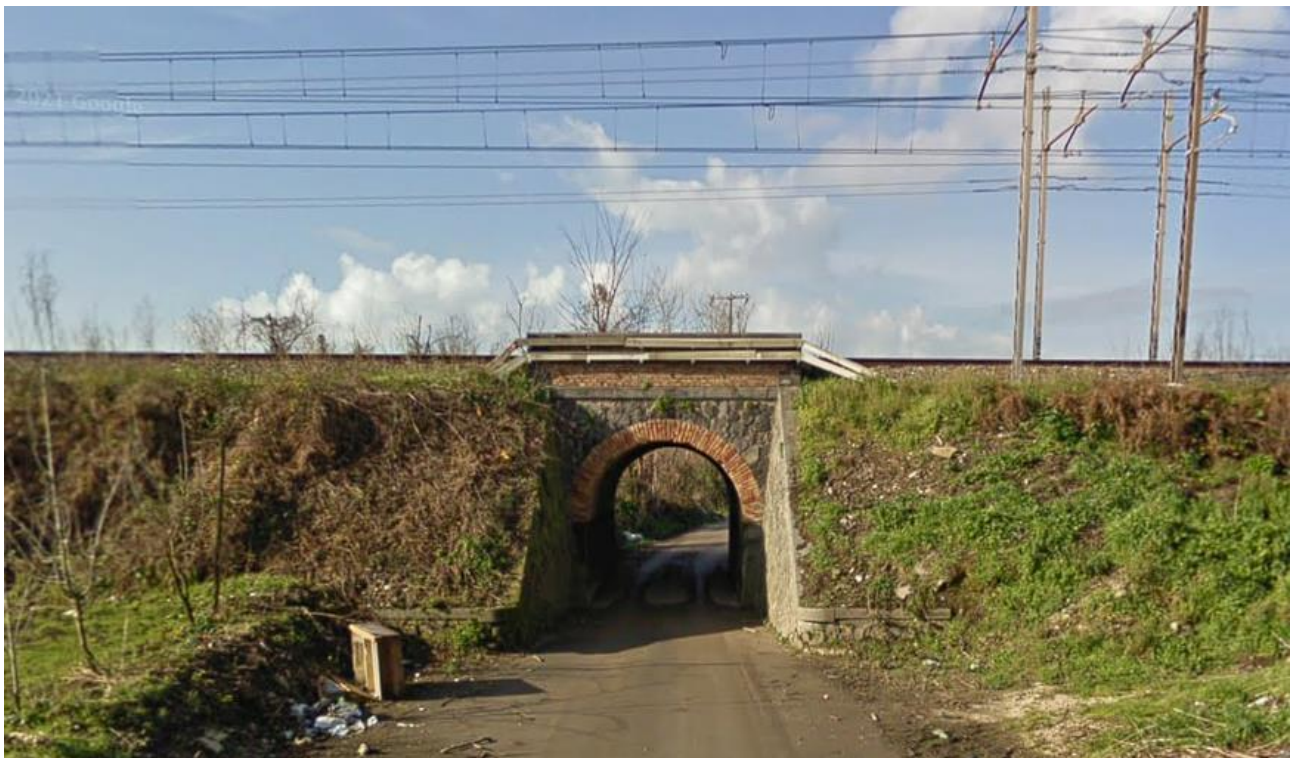
Sottopassaggio linea ferroviaria
