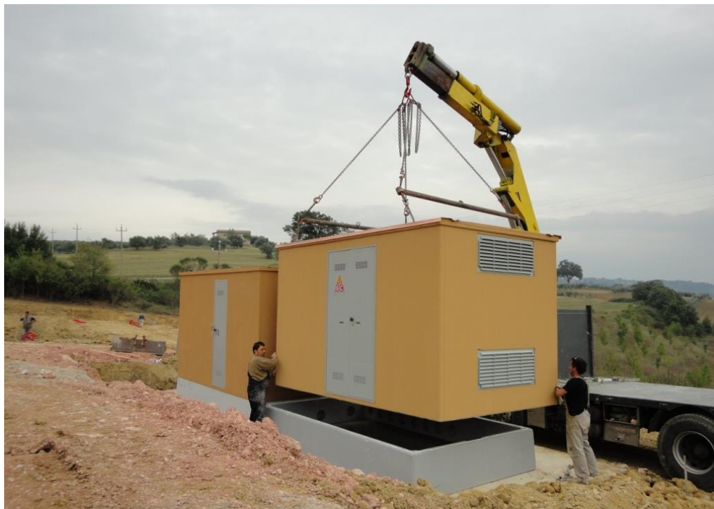
Installazione cabine elettriche prefabbricate
