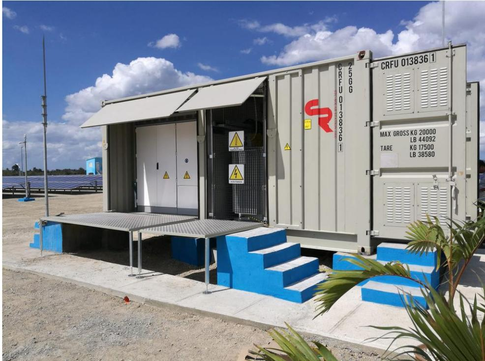
*Immagine di una cabina ISO 20' contenente inverter e trasformatore*
