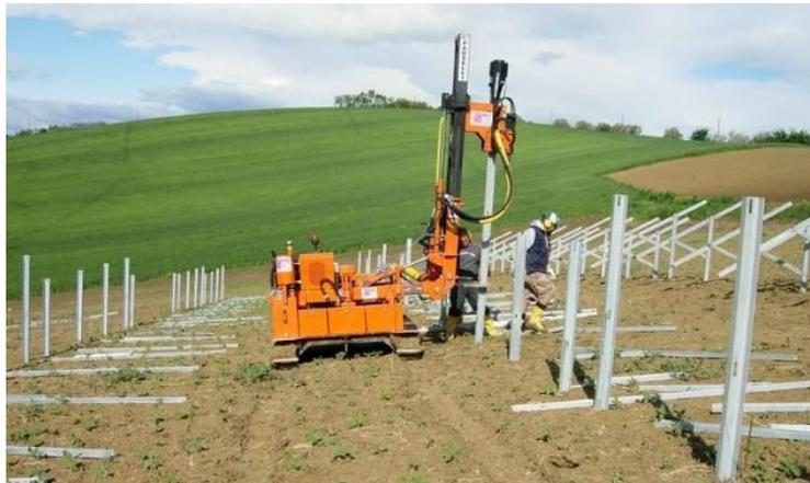
Infissione nel terreno della struttura di supporto dei moduli fotovoltaici
