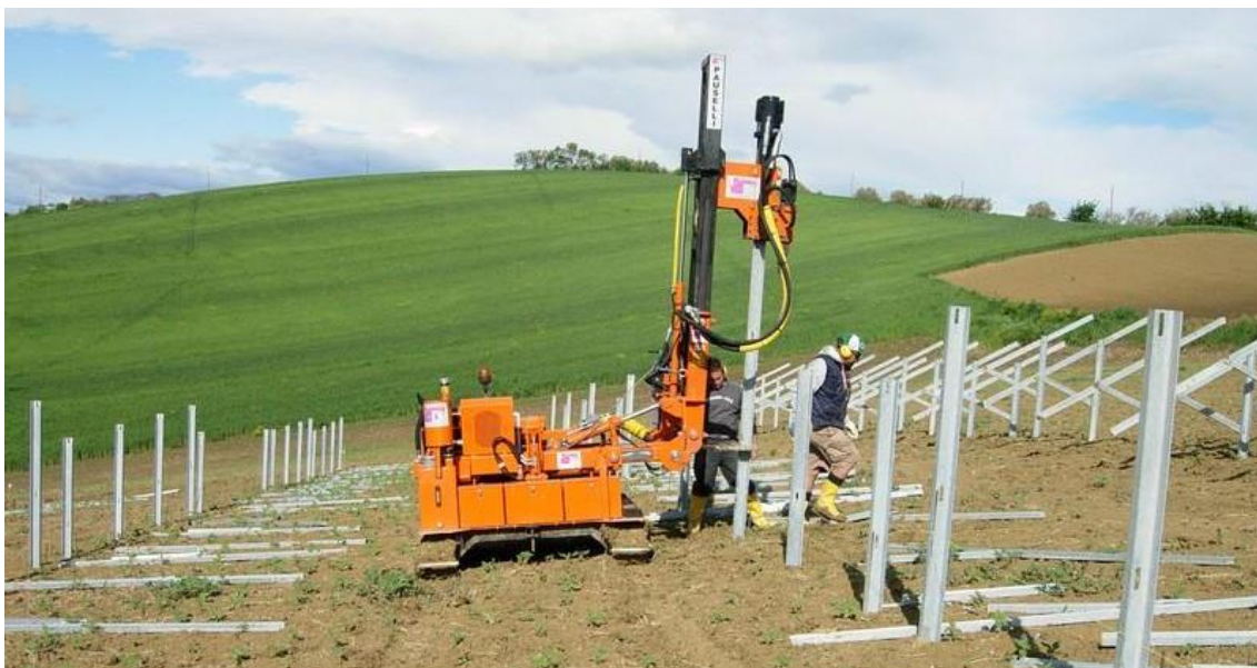
Battipali per la struttura di supporto degli inseguitori solari
