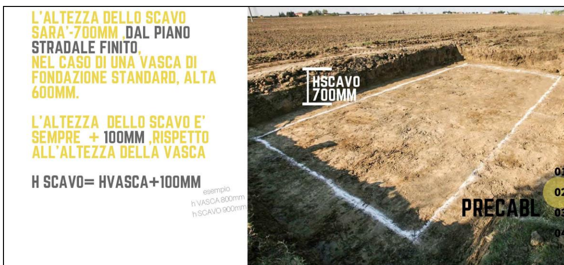
Opere di scavo cabine elettriche
