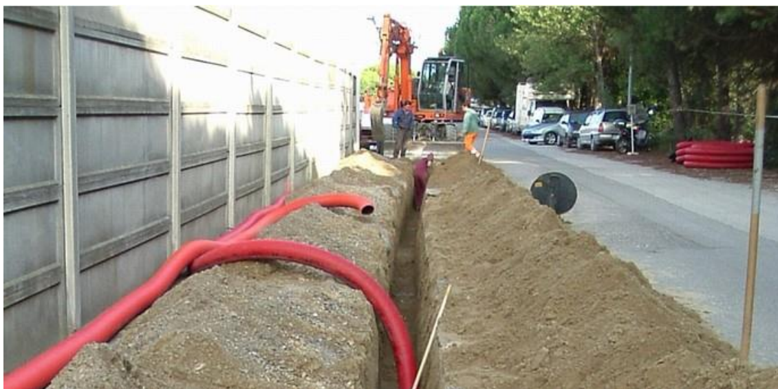
Cantiere per linea elettrica di media tensione interrata su strada asfaltata
