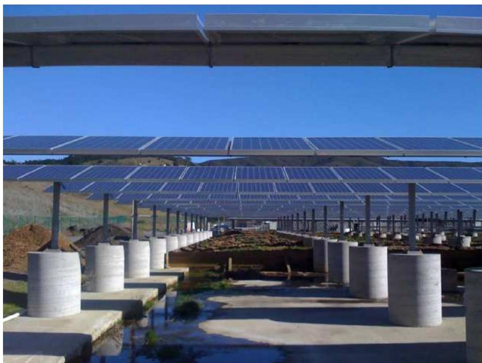
**Figura 14.** Esempio di impianto fotovoltaico con fondazioni formate da zavorre costituite da plinti in cemento
