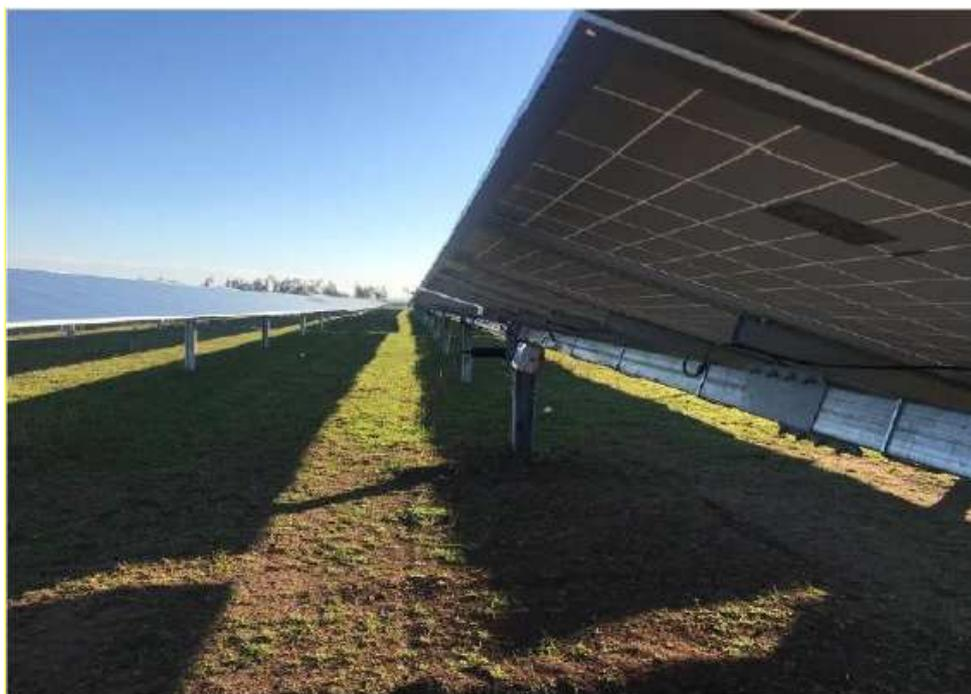
**Figura 12.** Esempio di impianto fotovoltaico realizzato con supporti costituiti da pali in acciaio infissi direttamente nel terreno
