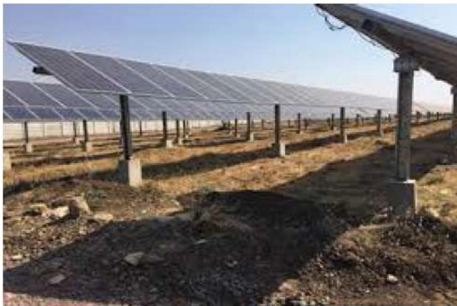
**Figura 13.** Esempio di impianto fotovoltaico con fondazioni ottenute mediante perforazione del terreno e successiva creazione del palo di fondazione con getto di cemento.
