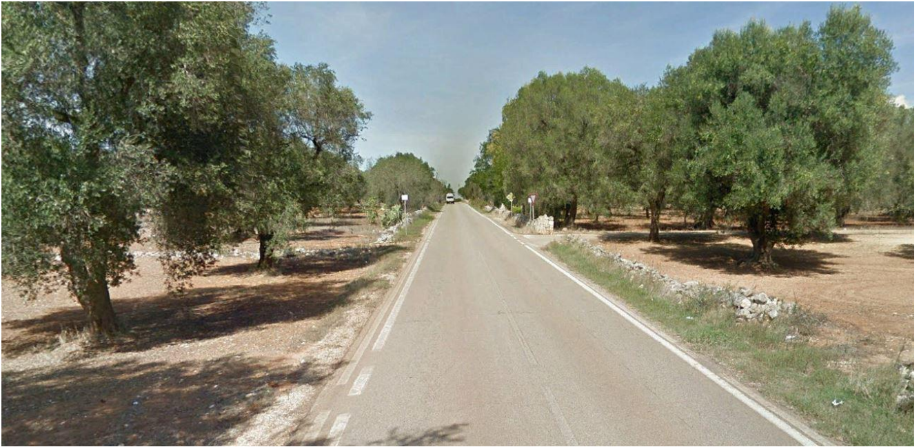
Figura 4-2: SP46 verso l'impianto direzione ovest
