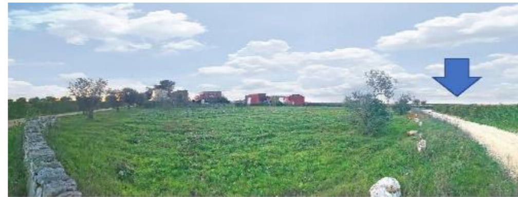
Masseria Cazzato: Vista panoramica ante operam
