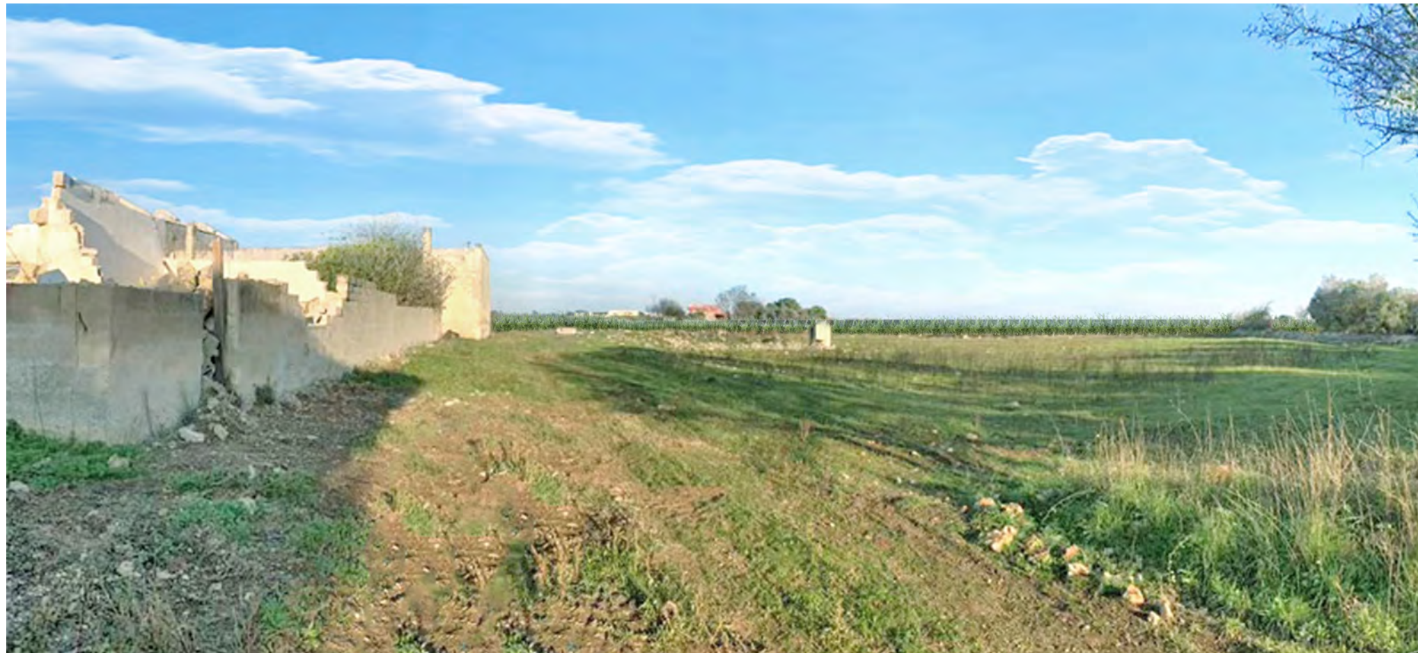
VISUALE PANORAMICA I- post operam
