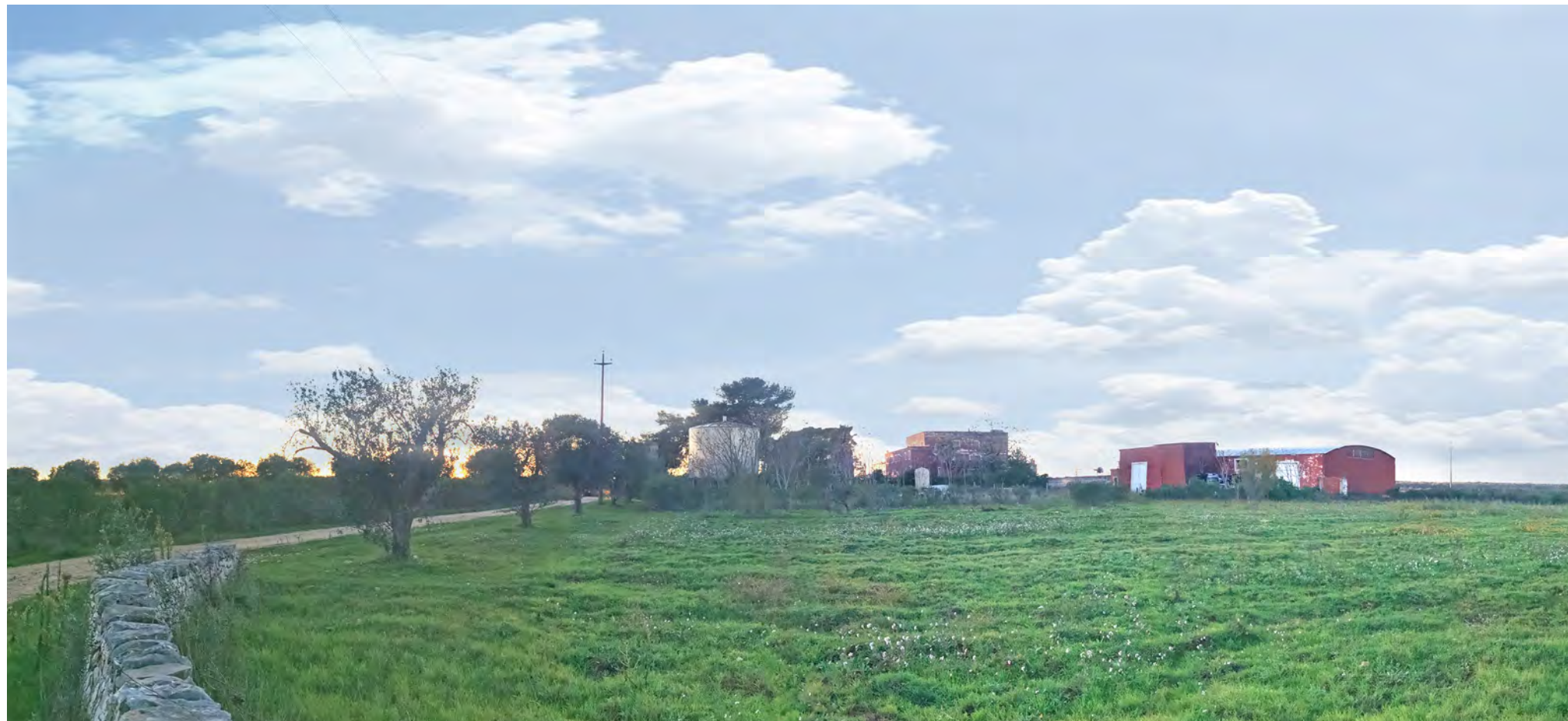
VISUALE PANORAMICA II- ante operam
