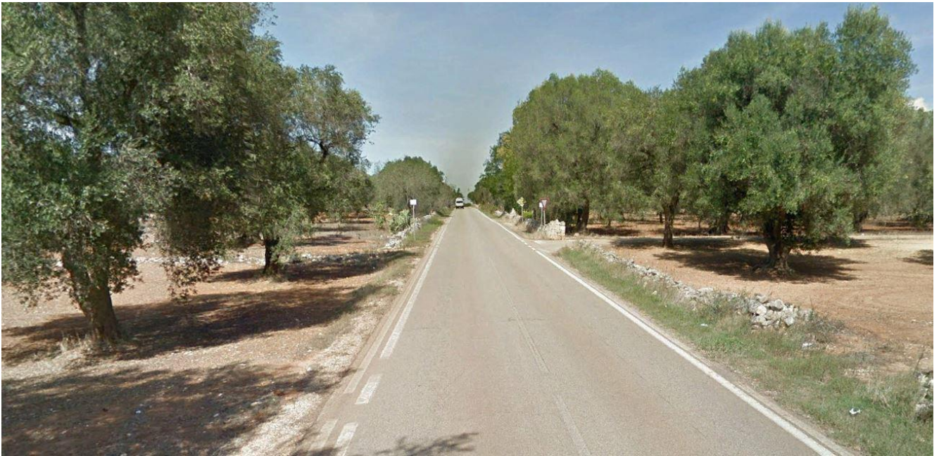
Figura 4-2: SP46 verso l'impianto direzione ovest
