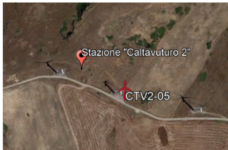
Figura 3-1: Inquadramento stazione anemometrica "Caltavuturo 2"
