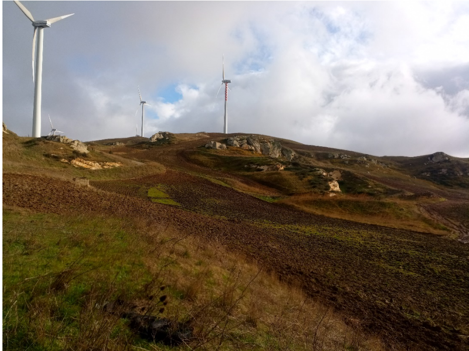
Figura 9: Vista panoramica impianto di Valledolmo (da notare le alternanze in affioramento di bancate arenacee e coltri argilloso-limose)
