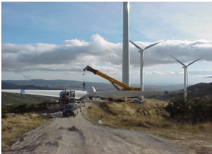
**Figura 3-2: Ingombro del rotore a terra**
