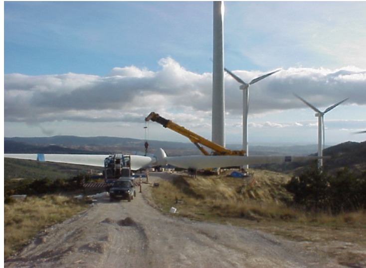
Figura 2-3: Ingombro del rotore a terra
