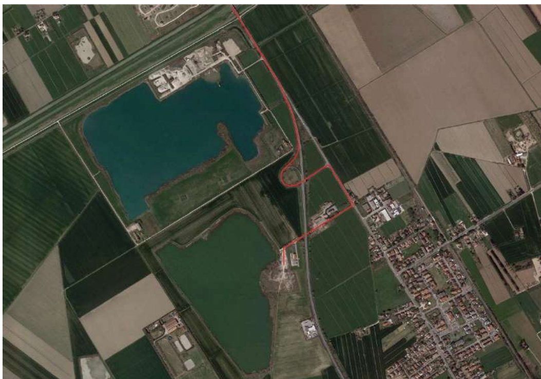
Viabilità di accesso al cantiere dalla rotatoria esistente sulla SP16.
