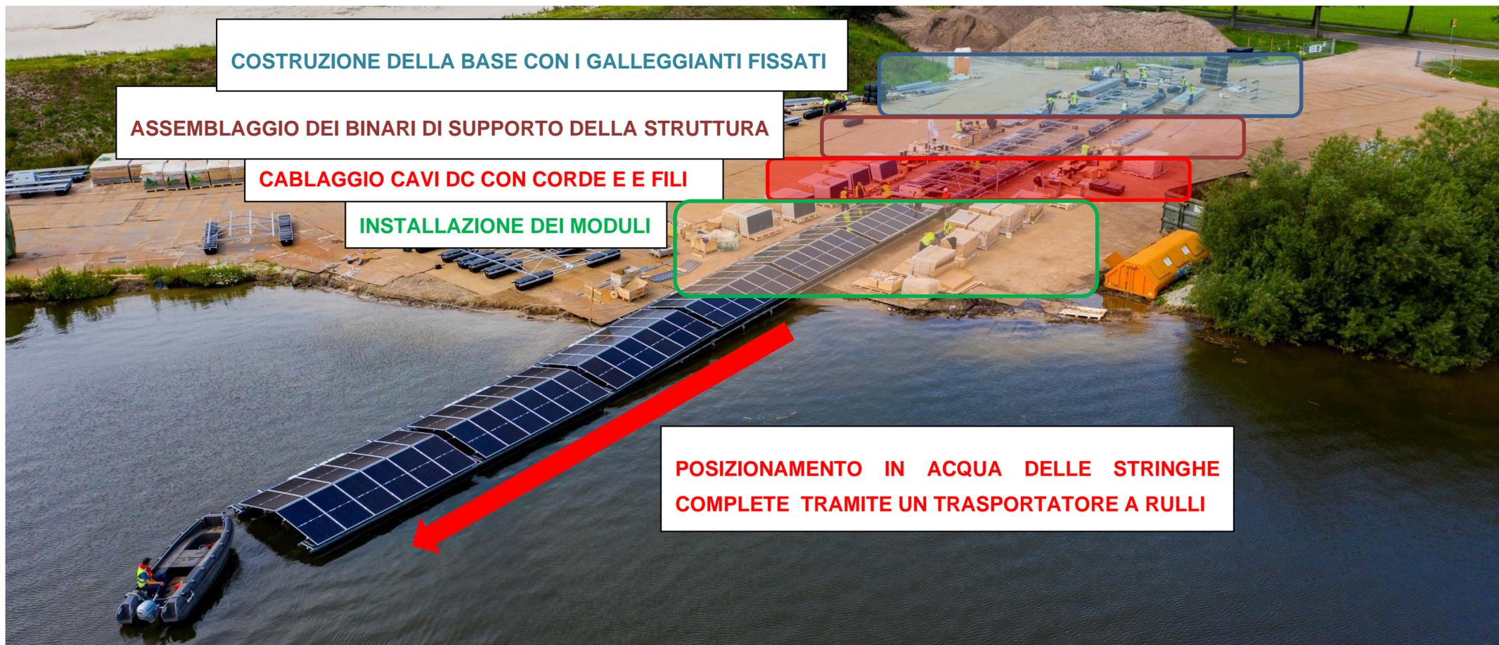
Figura 20. Fasi di assemblaggio
