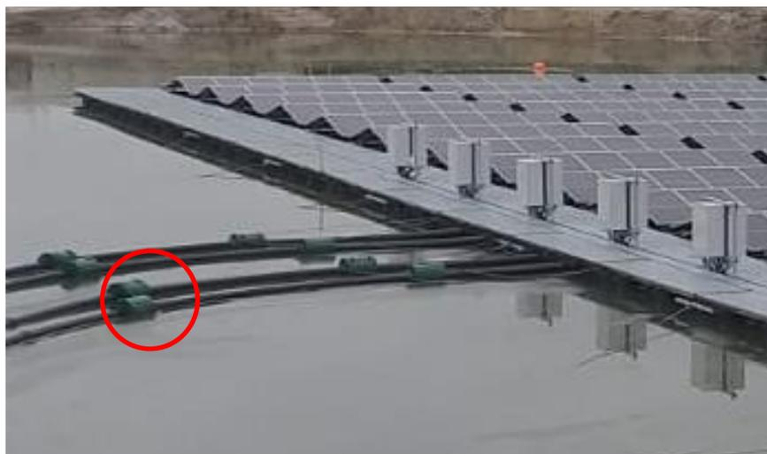
**Figura 10.** Cablaggio con sistemi di galleggiamento
