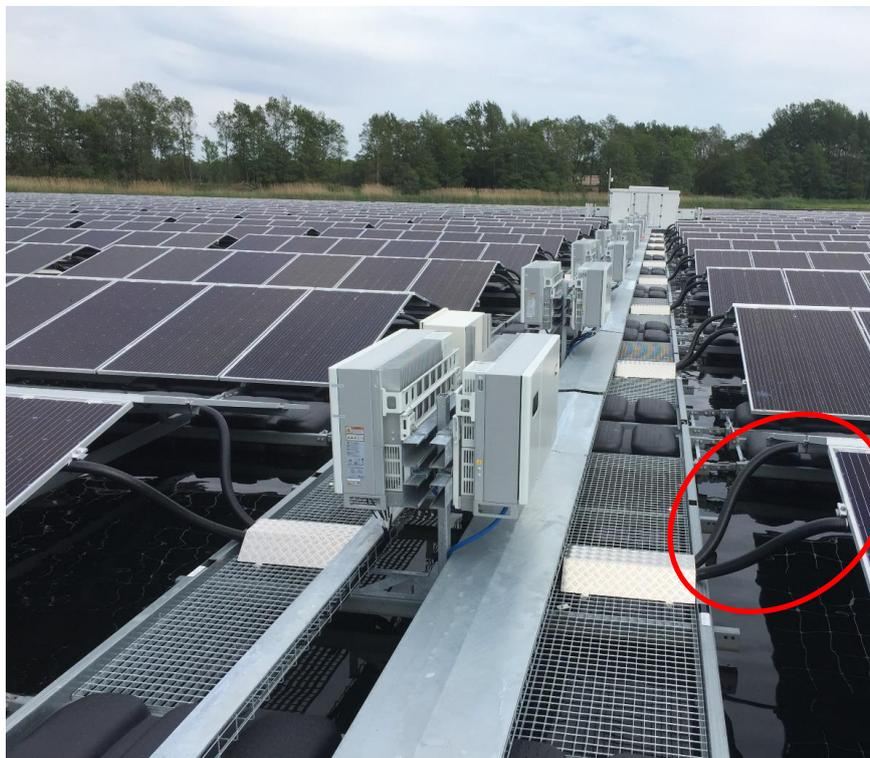
**Figura 18.** Esempio di cablaggio flessibile
