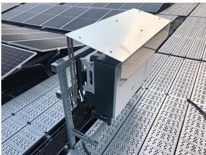
**Figura 7.** Inverter con intelaiatura portante in acciaio.
