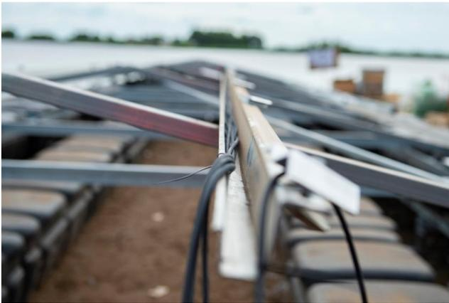
**Figura 24.** Fase 3 (cablaggio cavi dc con corde e e fili)
