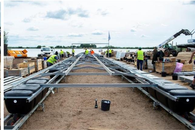
**Figura 21.** Fase 1 (costruzione della base con i galleggianti fissati pannelli)
