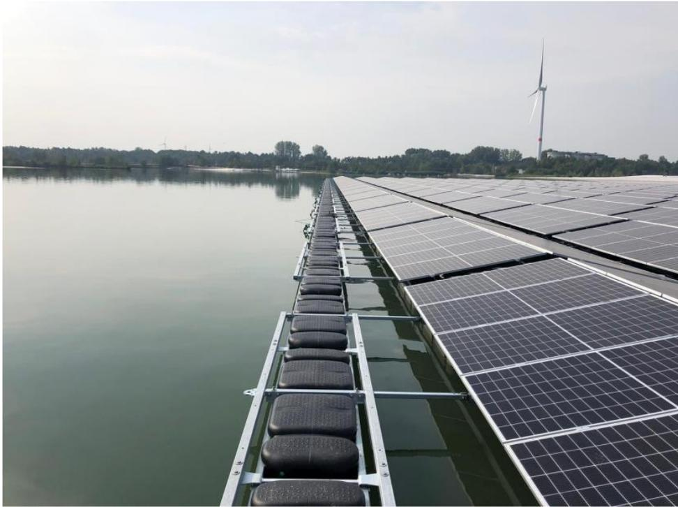
**Figura 11.** Barriera galleggiante di protezione
