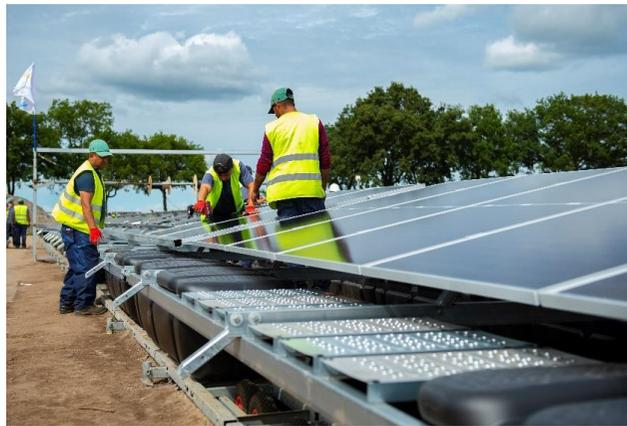
**Figura 25.** Fase 4 (Installazione moduli)
