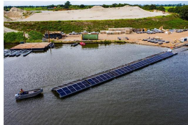
**Figura 26.** Fase 5 (posizionamento in acqua)
