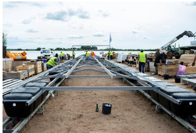
**Figura 29.** Fase 2 (Installazione supporto pannelli)
