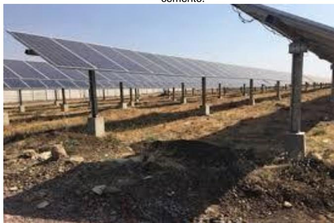
Figura 36 – Esempio di impianto fotovoltaico con fondazioni ottenute mediante perforazione del terreno e successiva
