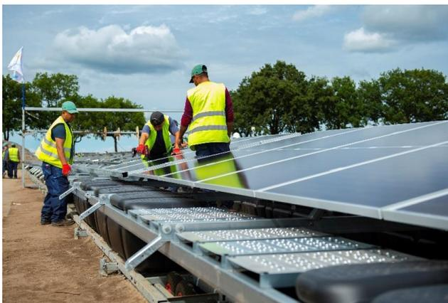
**Figura 31.** Fase 4 (Installazione moduli)
