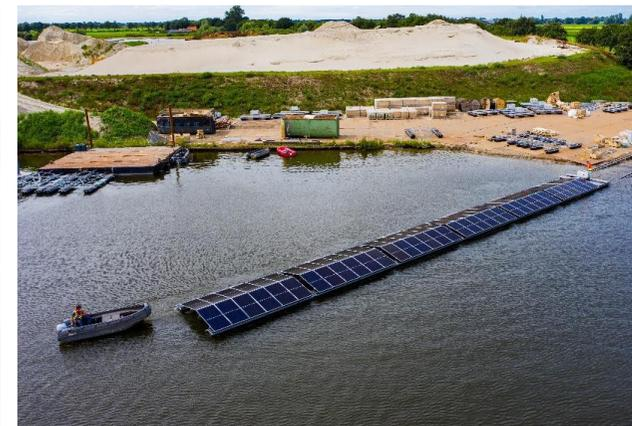
**Figura 32.** Fase 5 (posizionamento in acqua)
