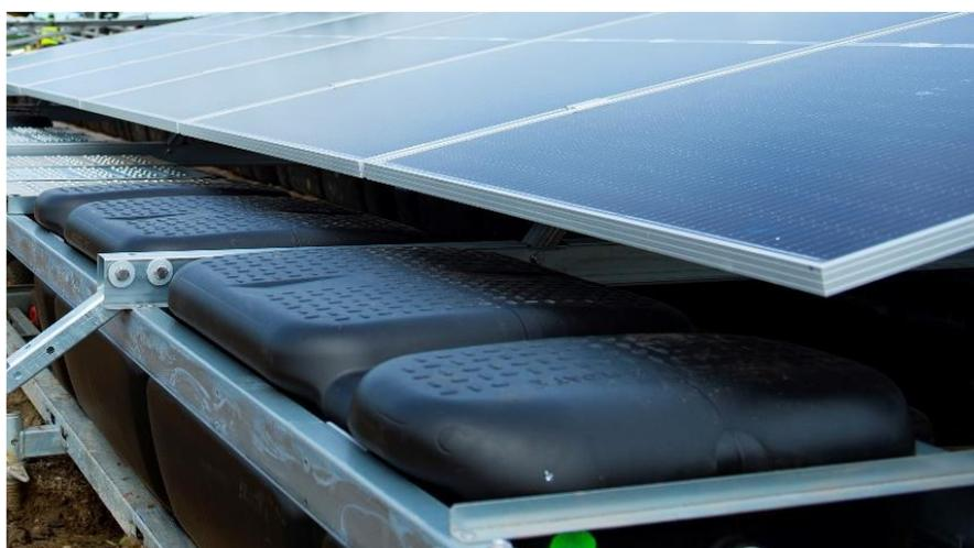
Figura 4. Galleggiante Z-Float 1 in HDPE
