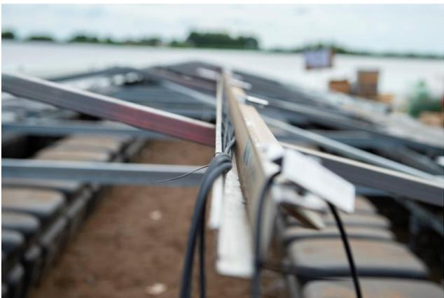
**Figura 30.** Fase 3 (cablaggio cavi dc con corde e e fili)
