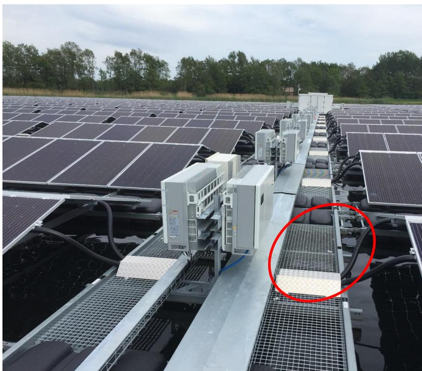
**Figura 23.** Esempio di cablaggio flessibile
