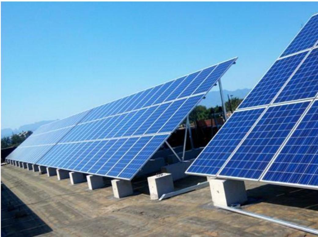
**Figura 38** – Esempio di impianto fotovoltaico con fondazioni formate da zavorre costituite da plinti in cemento.
