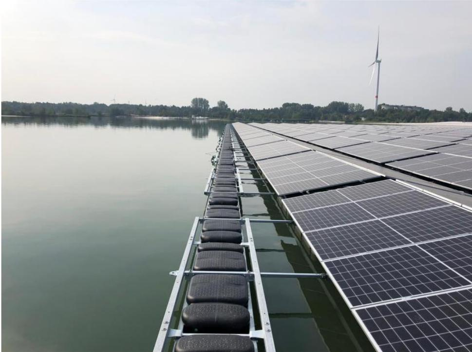
**Figura 11.** Barriera galleggiante di protezione
