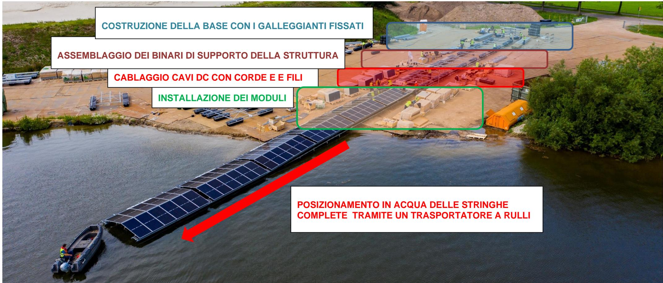
Figura 26. Fasi di assemblaggio
