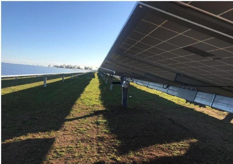
Figura 34 – Esempio di impianto fotovoltaico realizzato con supporti costituiti da pali in acciaio infissi direttamente nel terreno.
