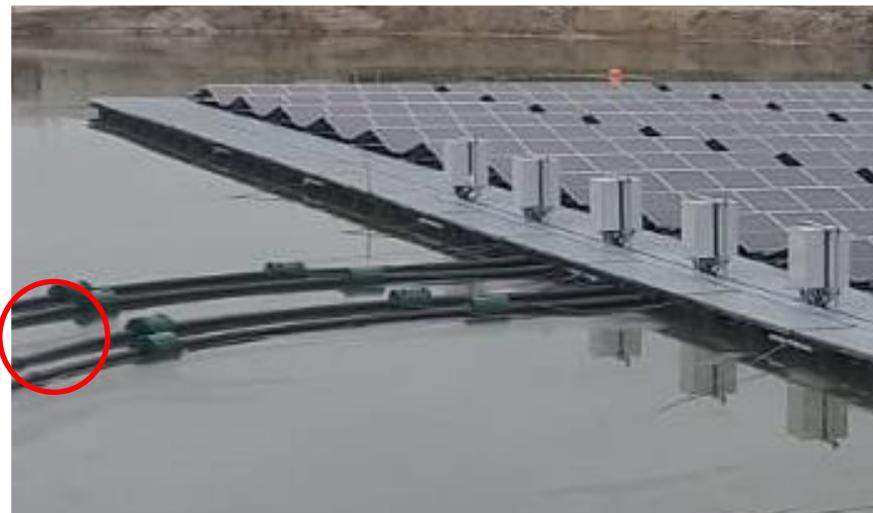
**Figura 10.** Cablaggio con sistemi di galleggiamento
