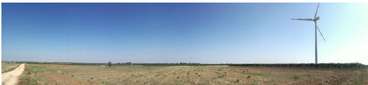
Foto -3 Sito B sede della sottostazione
