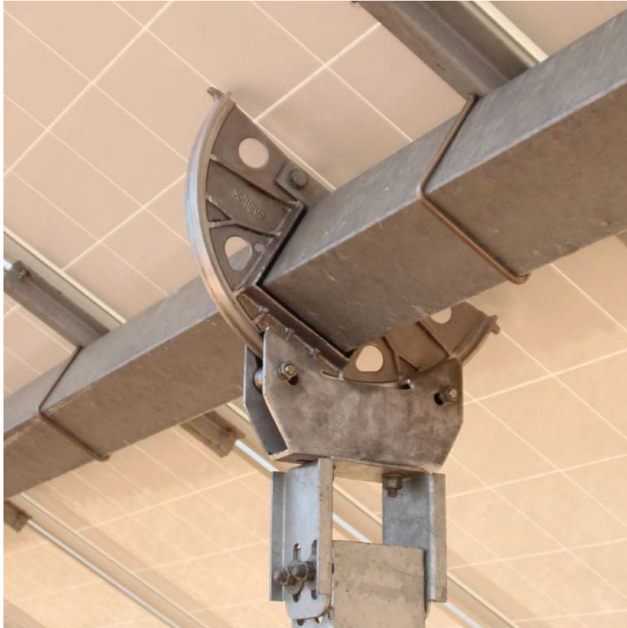
Schema nodo trave-pilastrino
