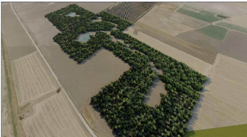
Fig.4 Area di compensazione ed impianto fotovoltaico
