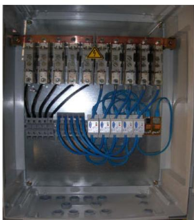
Ogni quadro sarà dotato di 5 ingressi captando 5 box GAK, per una potenza complessiva di 100KWp, ognuno di essi sarà dotato dei seguenti organi di sezionamento e protezione.
