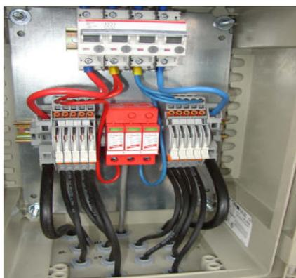
I quadri saranno realizzati in lamiera adatti per l'installazione all'esterno e con protezione IP-65.
