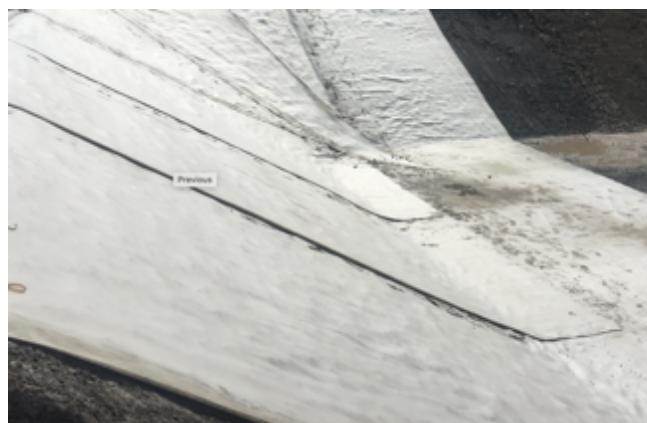
Esempio di "geocomposito bentonitico"
