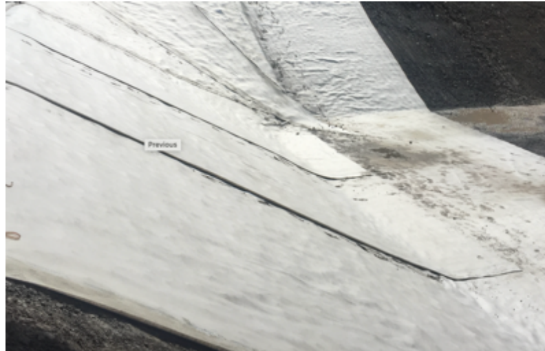
Esempio di “geocomposito bentonitico”
