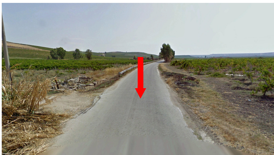
Vista attraversamento C.
