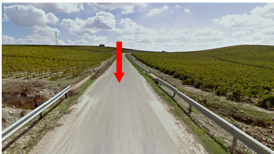
Vista attraversamento A.
