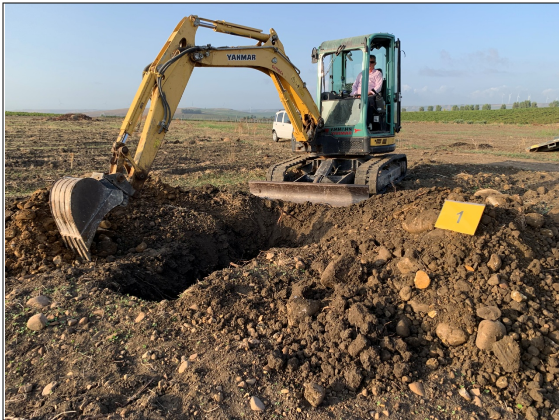
Scavo a pozzo in corrispondenza della Torre 1
