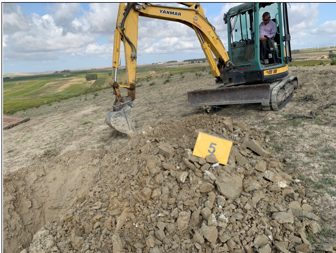
Scavo a pozzo in corrispondenza della Torre 5
