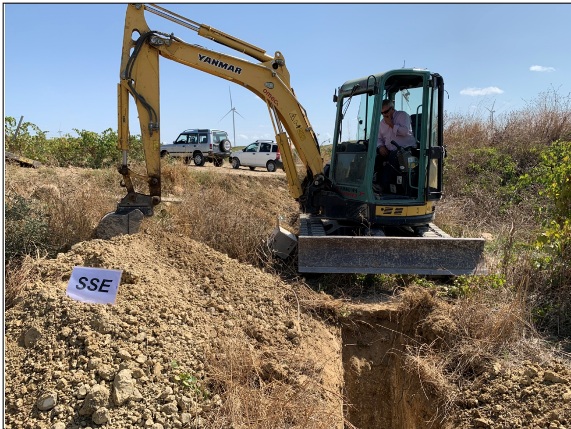
Scavo a pozzo in corrispondenza della SSE
