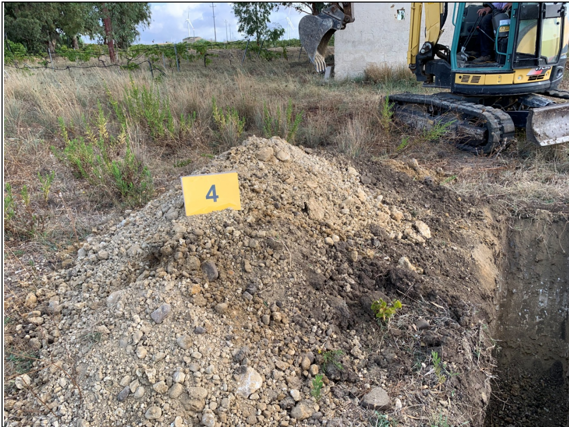
Scavo a pozzo in corrispondenza della Torre 4
