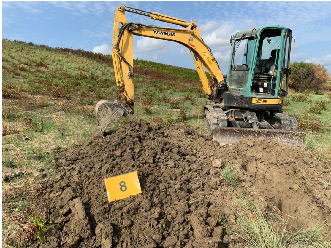
Scavo a pozzo in corrispondenza della Torre 8
