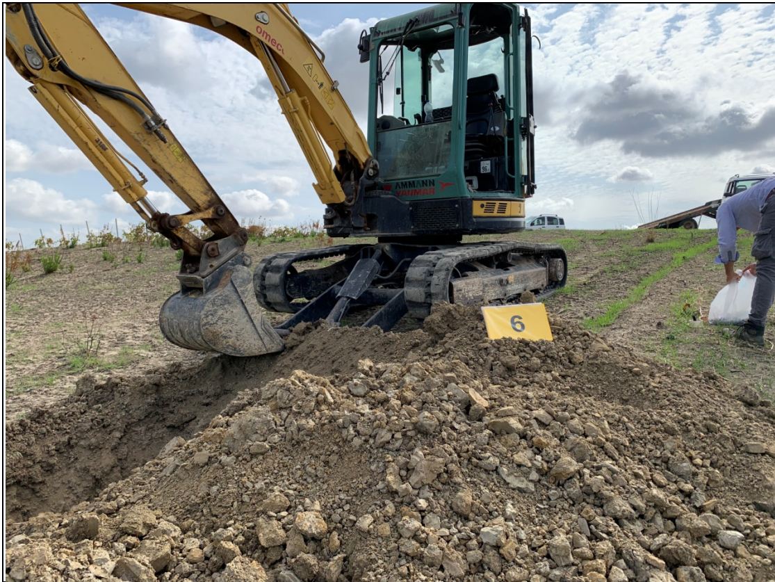
Scavo a pozzo in corrispondenza della Torre 6
