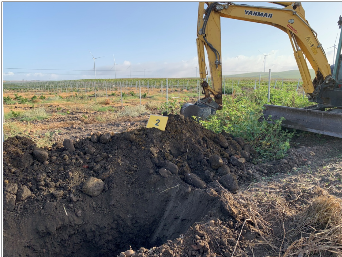
Scavo a pozzo in corrispondenza della Torre 2
