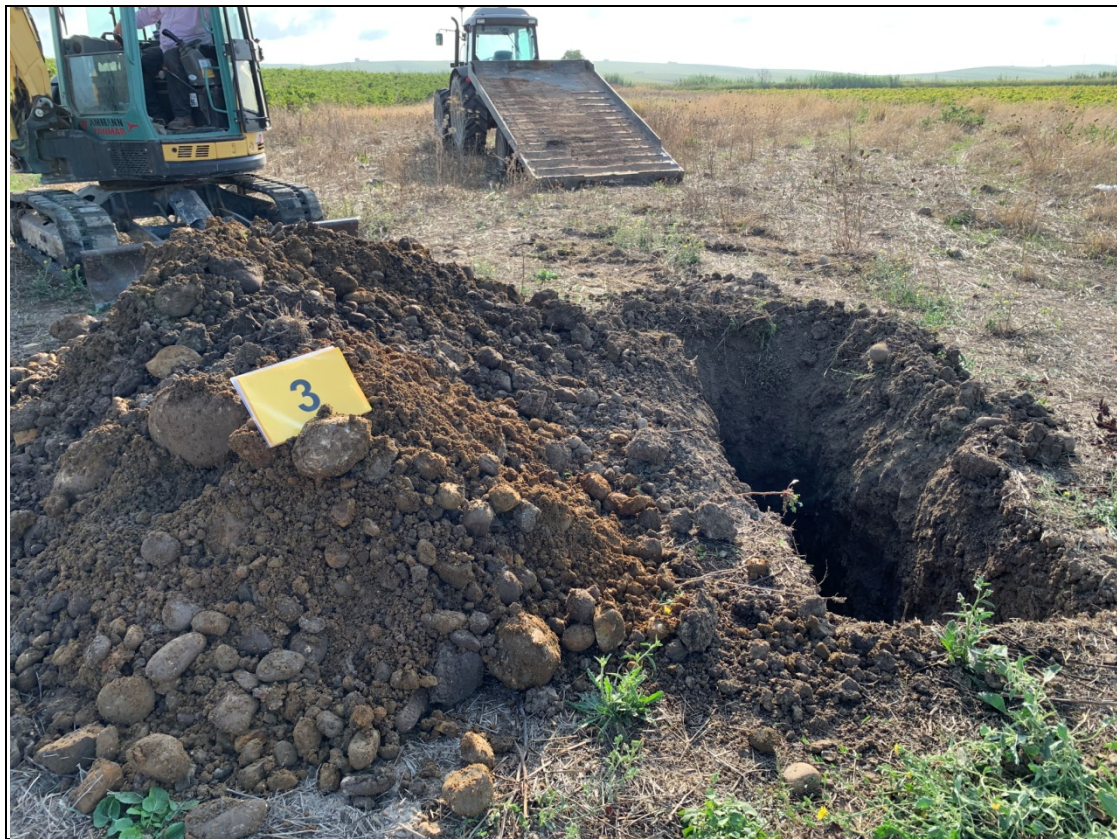
Scavo a pozzo in corrispondenza della Torre 3
