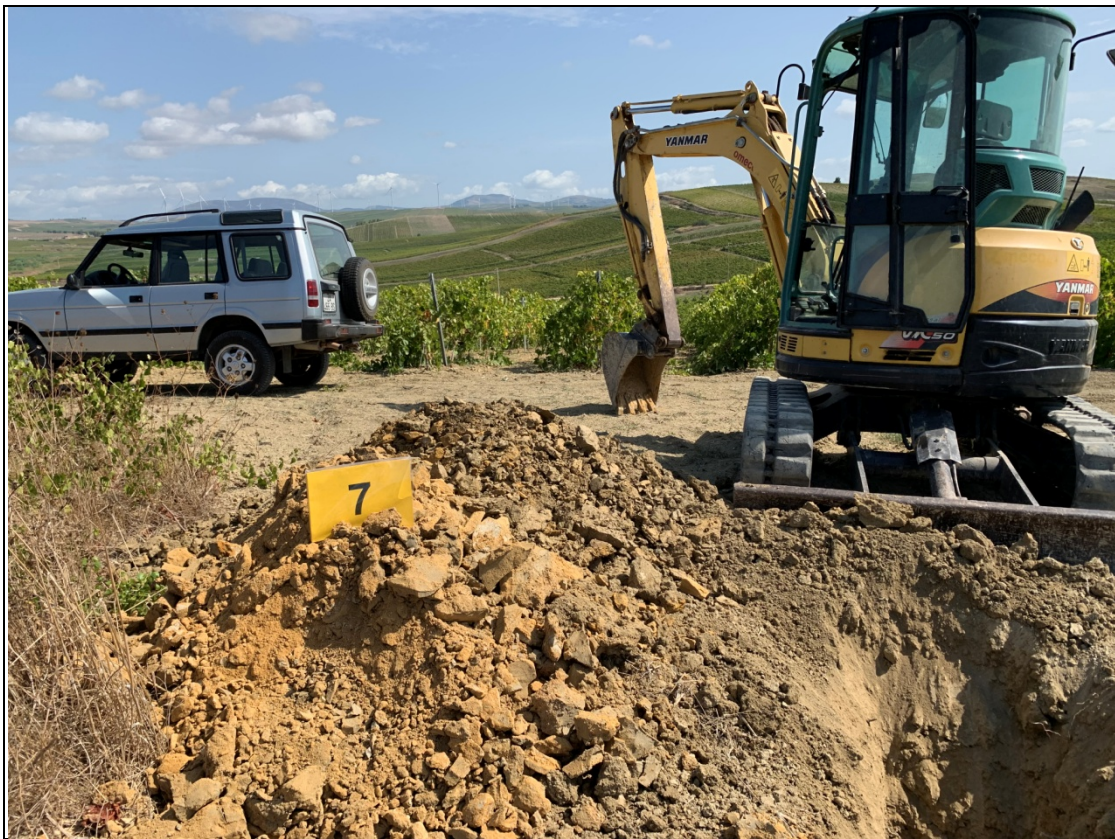
Scavo a pozzo in corrispondenza della Torre 7
