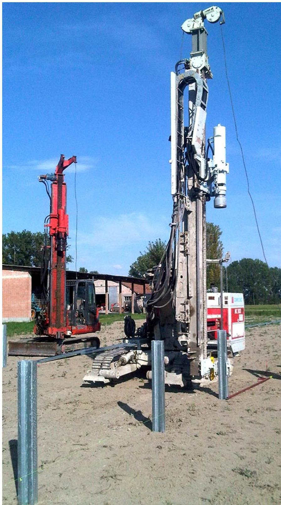
Figura 2.2: Esempio di Macchina Operatrice Battipalo
