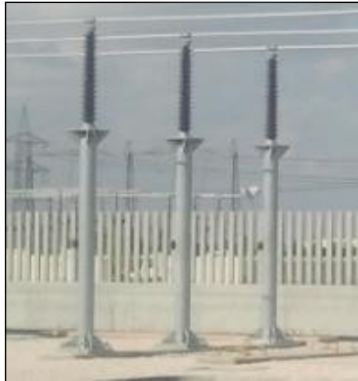
Figura 9.16. Particolare in foto dei supporti
