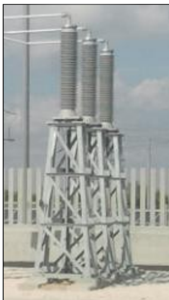
Figura 9.6. Terminale cavo AT Tipo.
