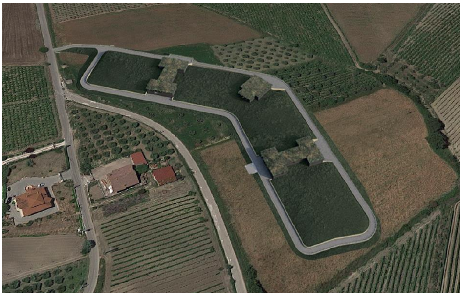
Fig. 5.20 - Serbatoio di accumulo
