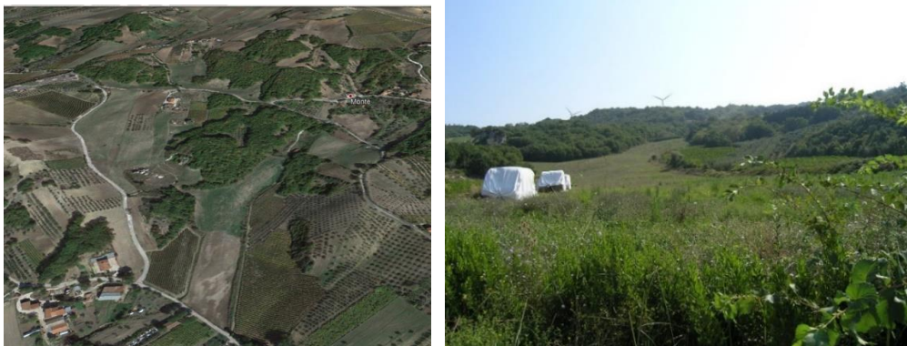
Fig 24 Foto dx: Area impianti veduta dall'alto; Foto sx: veduta dell'area impianti dalla strada comunale
