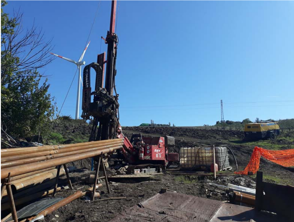
Postazione: sondaggio in corso
