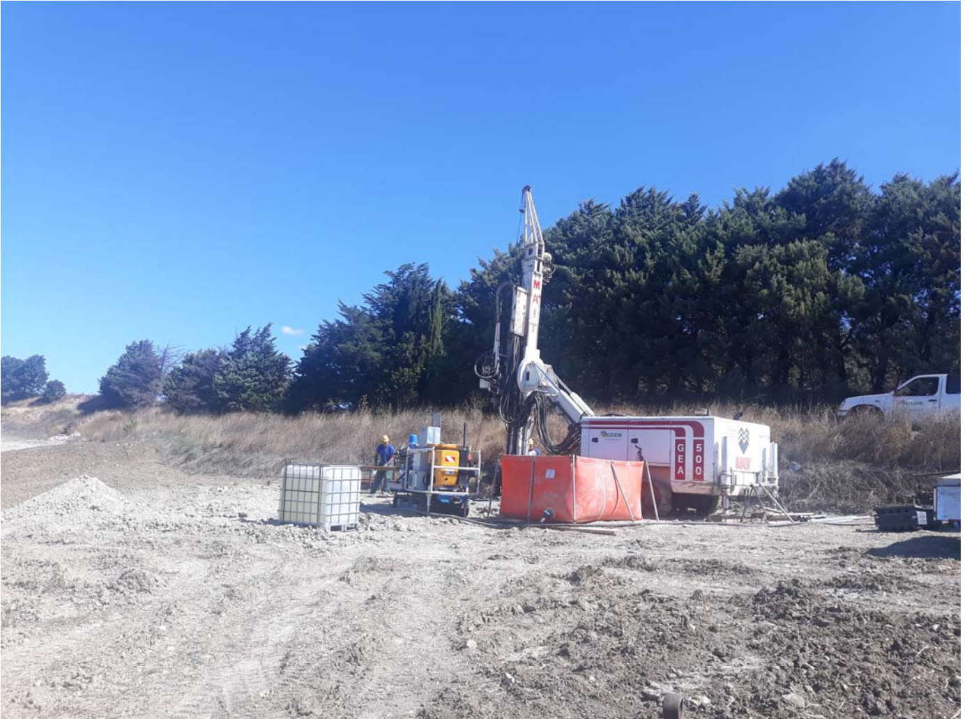
Postazione: sondaggio in corso
