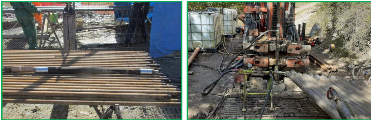
Figura 7: a sinistra, otturatore semplice utilizzato; a destra contaltri e manometri.
