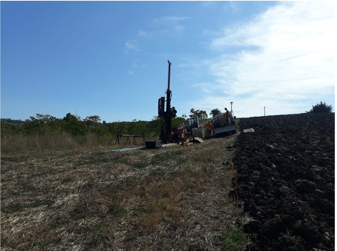
Postazione: sondaggio in corso
