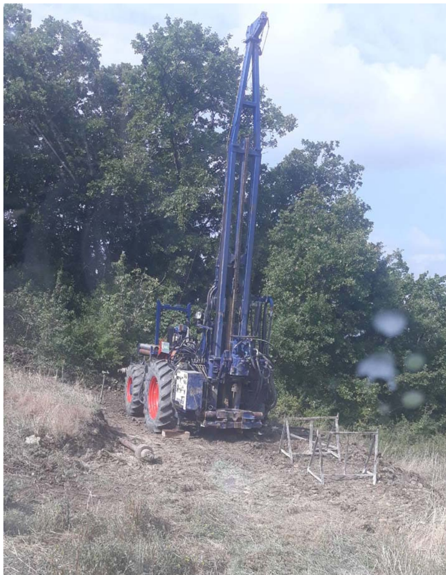
Postazione: sondaggio in corso
