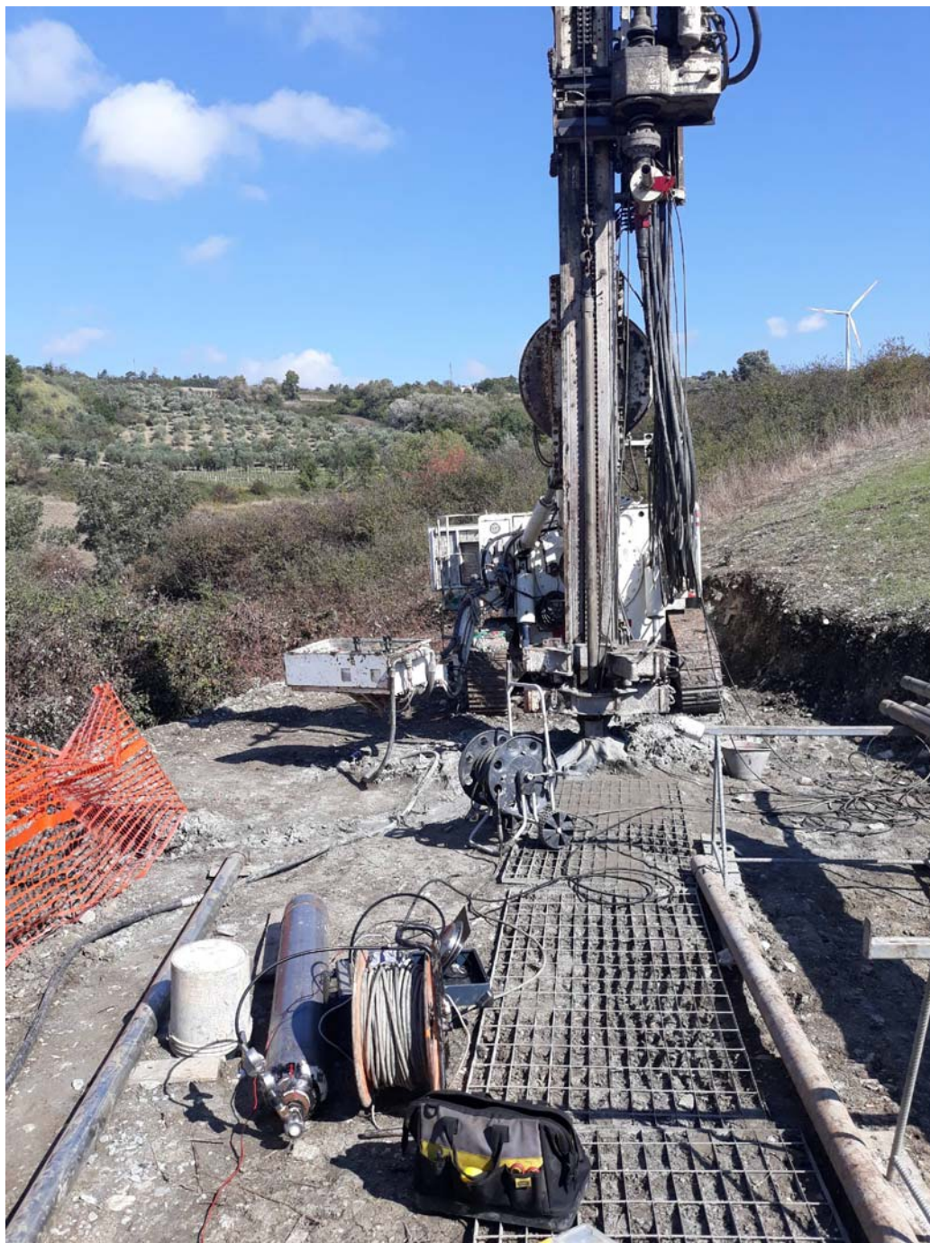
Postazione: sondaggio in corso
