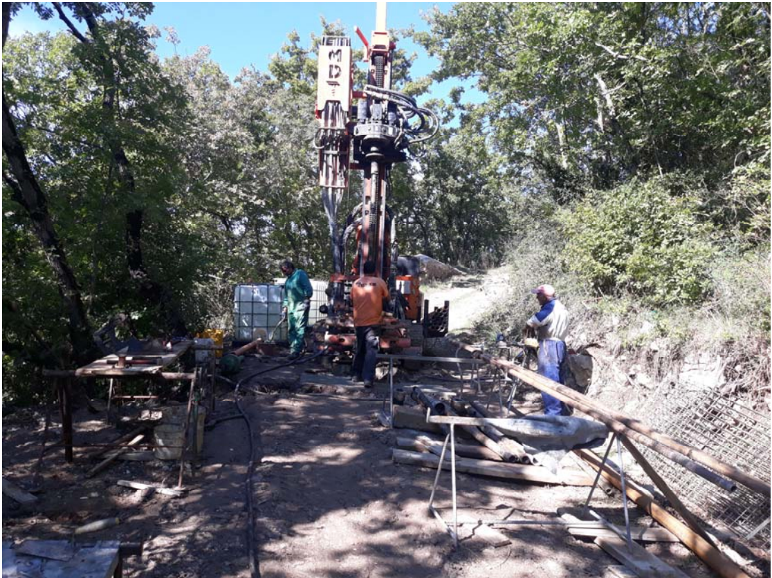
Postazione: sondaggio in corso
