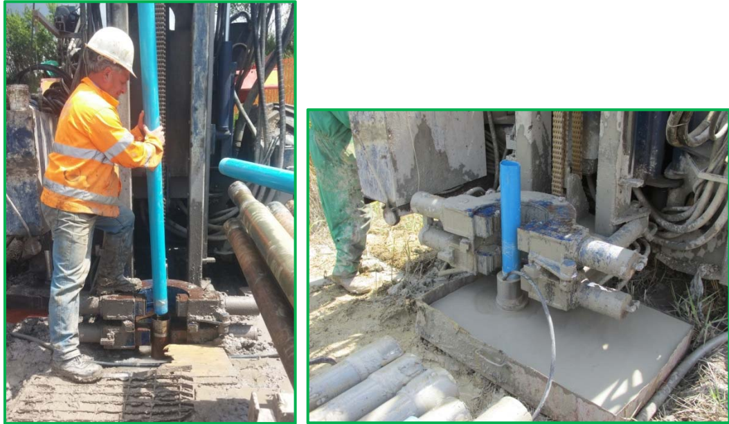
Figura 8: posa in opera tubo per prospezione down-hole; a destra, fase di cementazione.
