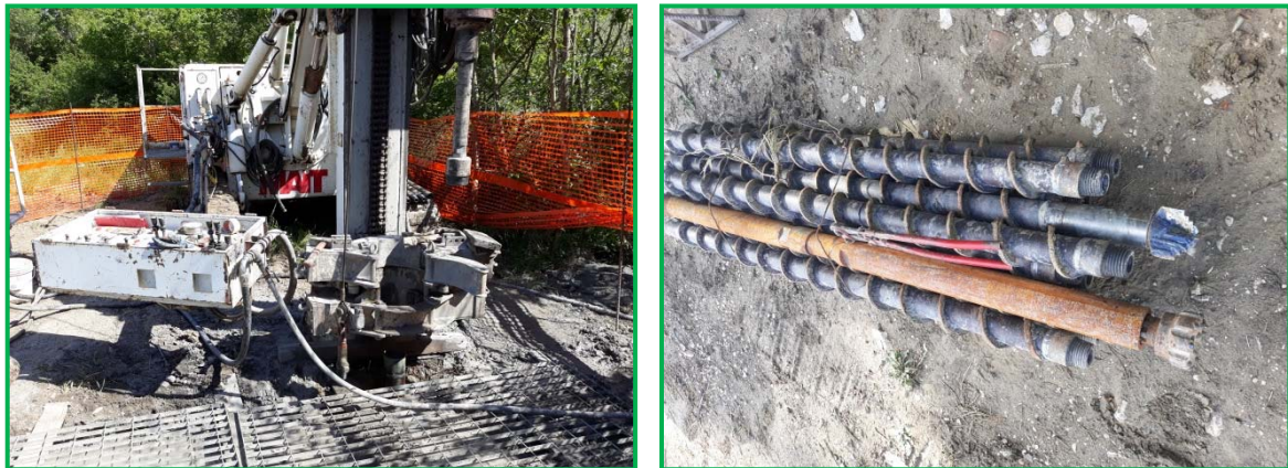
Figura 6: Sondaggio CL-6; a destra attrezzature per distruzione di nucleo.
