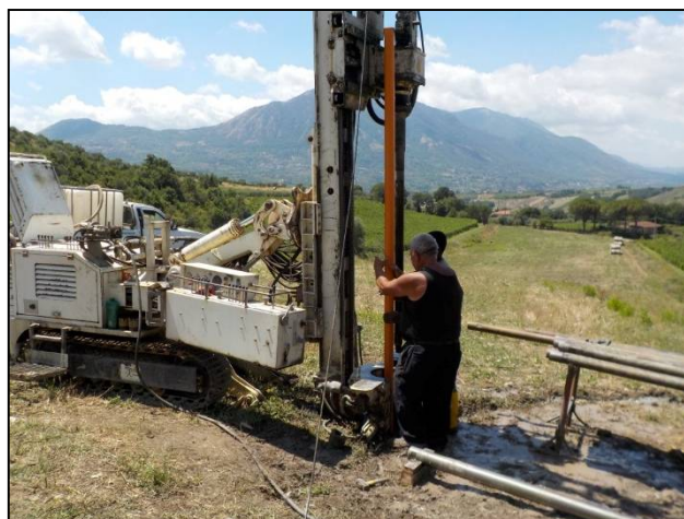
Installazione Piezometro
