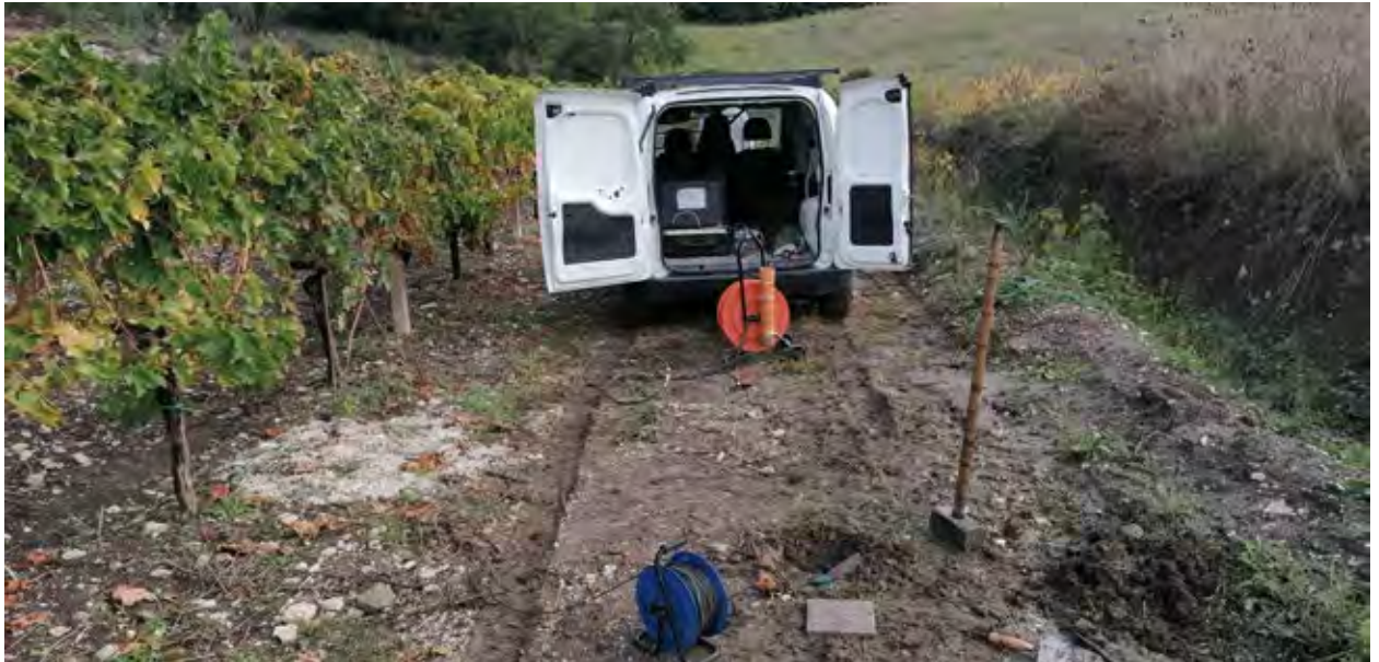
Foto 2: DH2-SG8 AREA IMPIANTI
