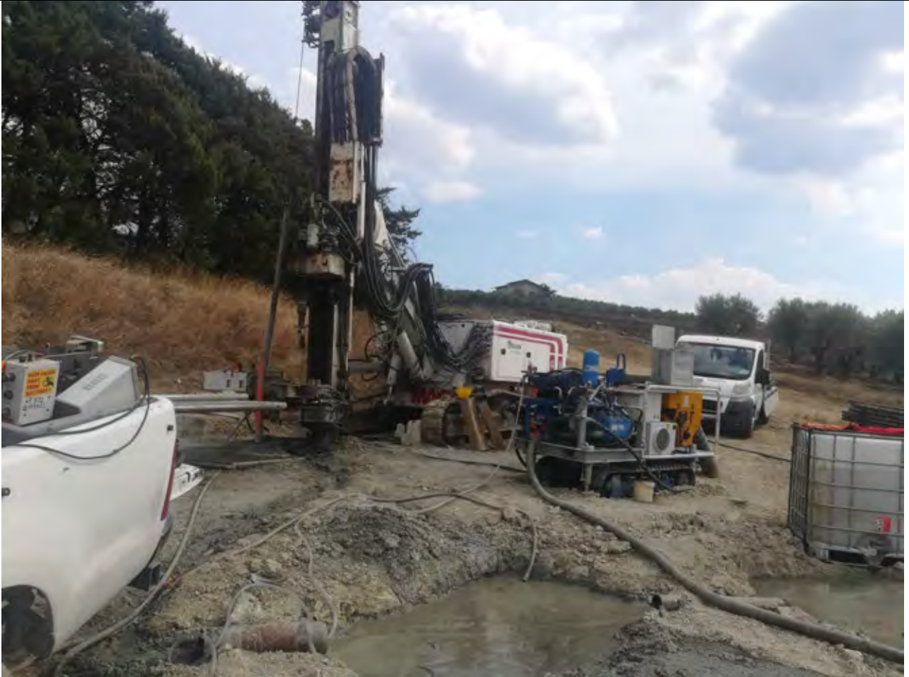
Fig. 3: Foto del sondaggio
