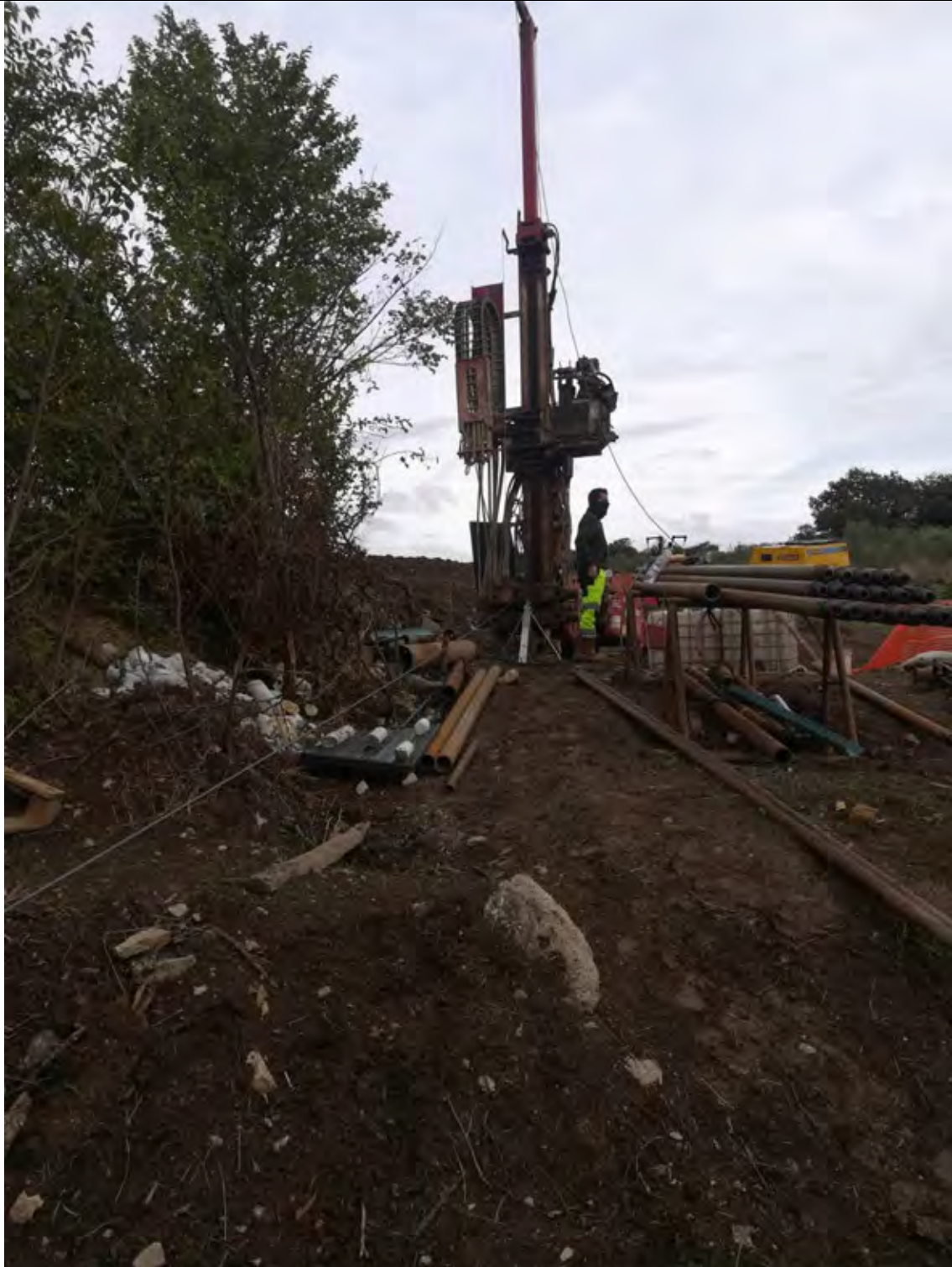
Fig. 2: Foto del sondaggio
