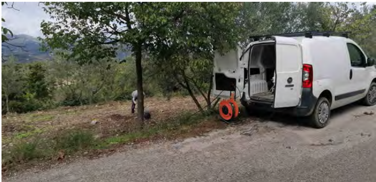
Foto 1: DH1- SG5 IMBOCCO GALLERIA TBM E TERRE ARMATE
