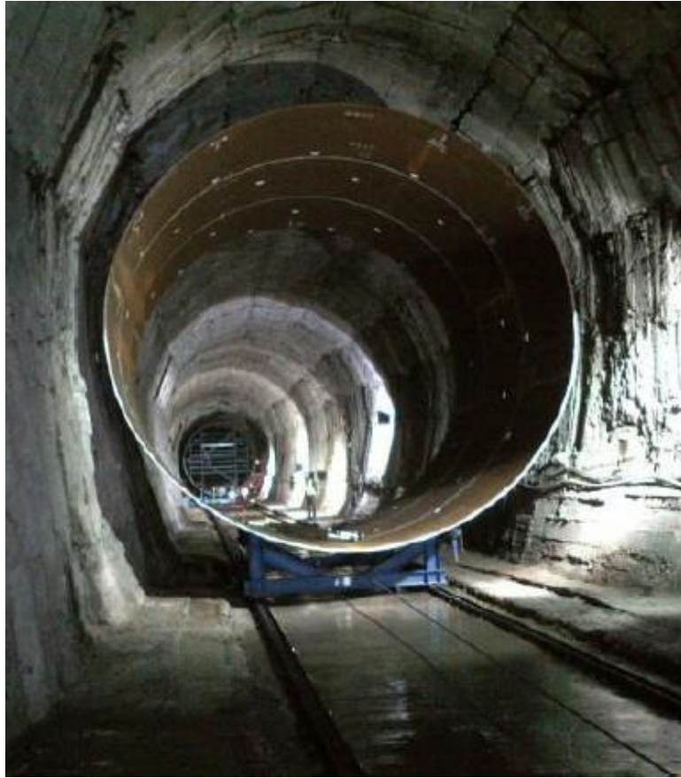
Figura 8 – Posa di una condotta in galleria (per gentile concessione Camuna)
