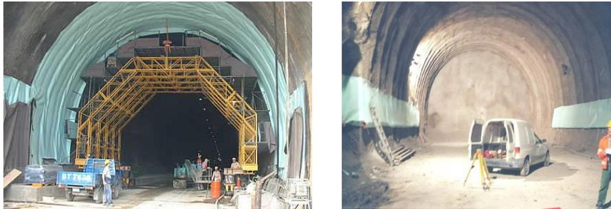
**Figura 27: Messa in opera impermeabilizzazione.**
