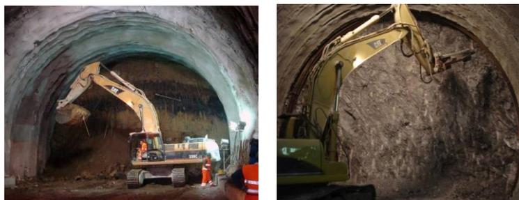
Figura 24: Scavo mediante pala meccanica (sinistra) e martellone (destra).
