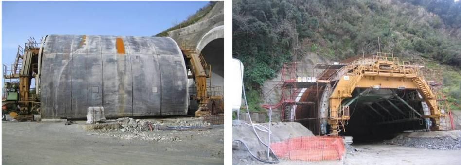
Figura 28: Casseri autoportanti per getti del rivestimento di calotta.
