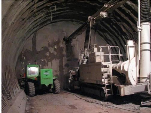
**Figura 21: Perforazioni al fronte scavo mediante posizionario.**
