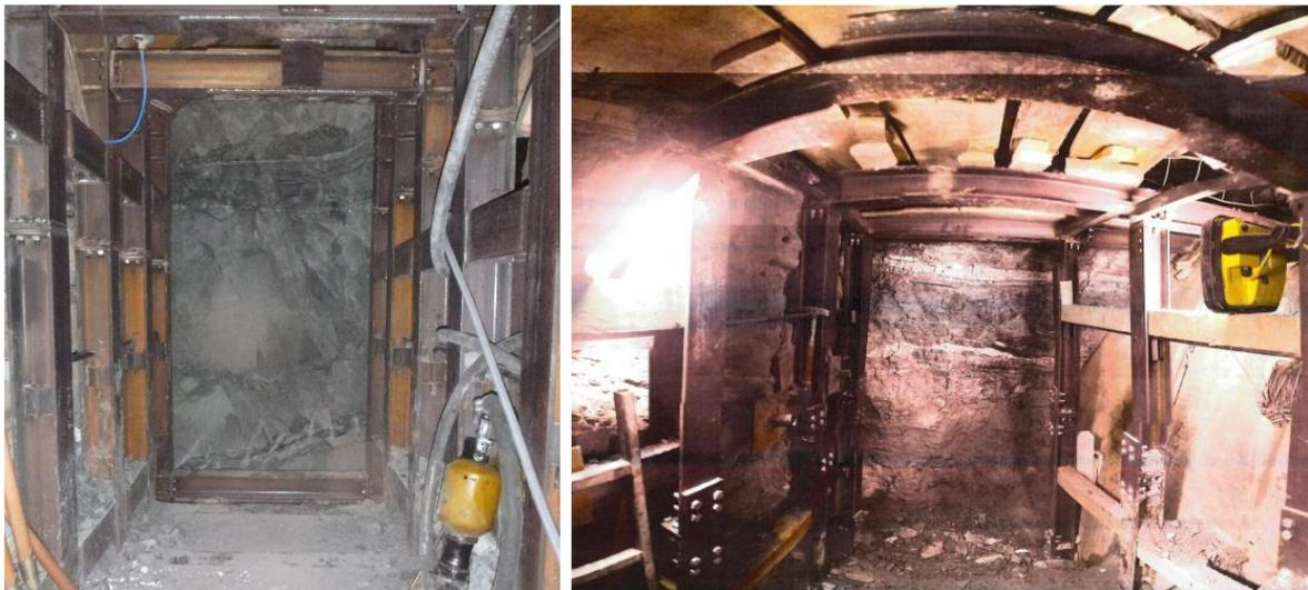
**Fig. 4.2 – Esempio di cunicolo di sblocco realizzato, galleria Pavoncelli Bis**
