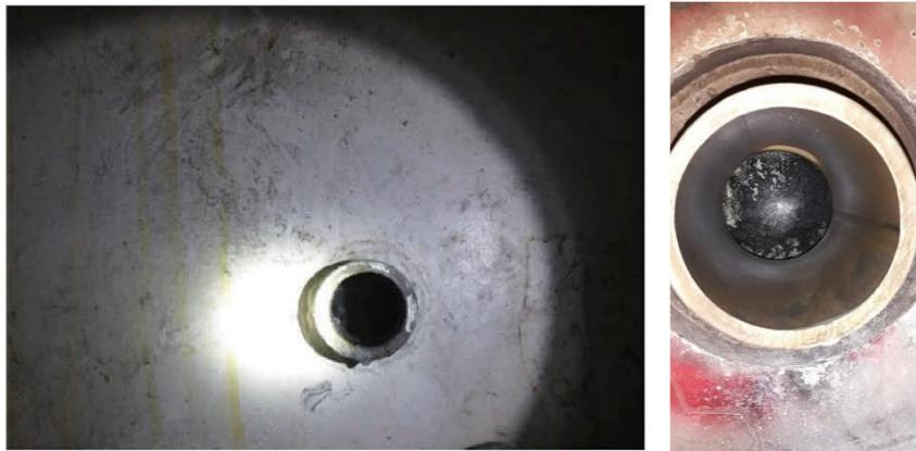
**Fig. 4.1 – Esempio di fori predisposti sullo scudo per l'intervento di idremolizione (sx), risultato ottenuto in seguito all'applicazione dell'intervento (dx)**
