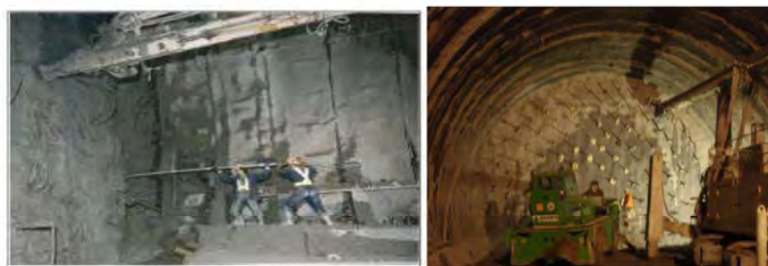
Figura 33: Messa in opera di elementi strutturali in VTR al fronte.
