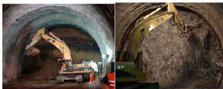
Figura 34: Scavo mediante pala meccanica (sinistra) e martellone (destra).
