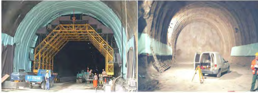
Figura 37: Messa in opera impermeabilizzazione.
