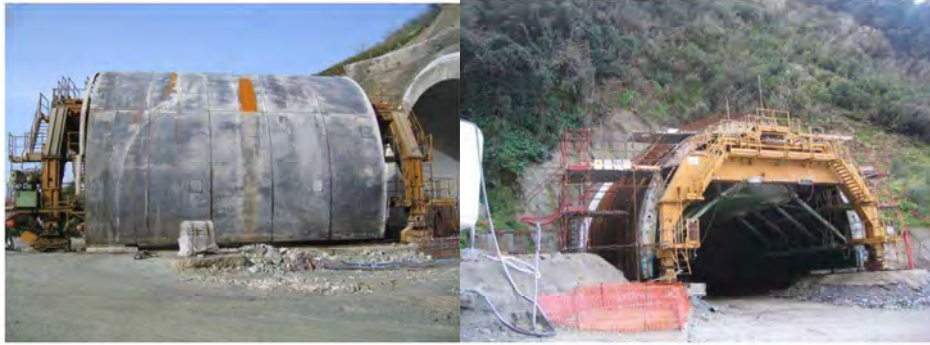
Figura 38: Casseri autoportanti per getti del rivestimento di calotta.
