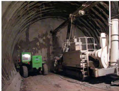
Figura 31: Perforazione al fronte mediante posizionatore
