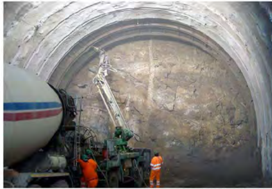
Figura 35: Messa in opera spritz beton sulle centine.
